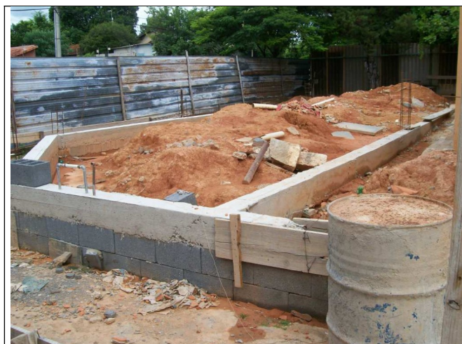
Figura 12 – Imagem da obra.
