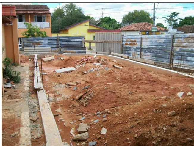
Figura 11 – Fotografia da obra já com as fundações concluídas.
