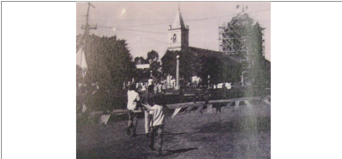
Figura 5 - Igreja Matriz de Santo Antônio. No registro fotográfico verifica-se que a igreja estava passando por obra de ampliação. Esta correspondia à construção do altar-mor do templo. Nota-se que as vias que circundavam a praça ainda não eram pavimentadas.
