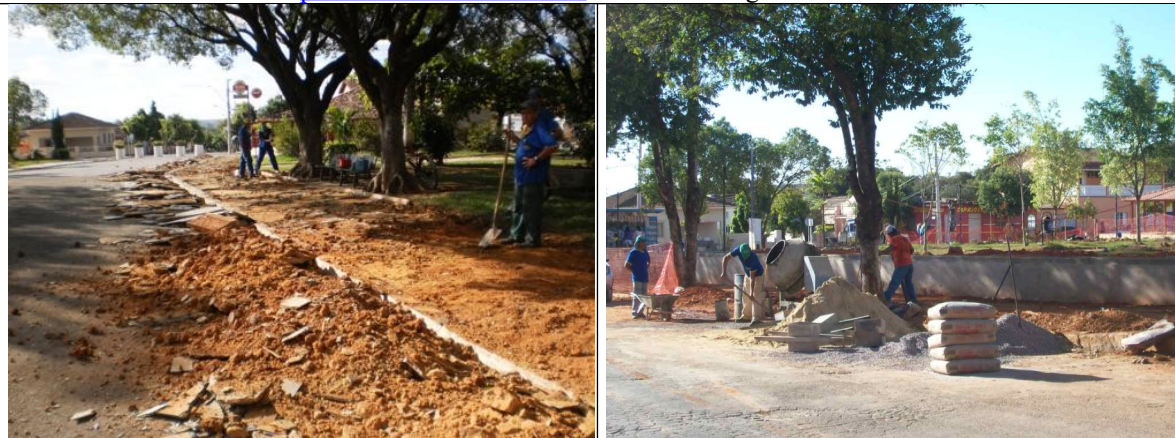
Figuras 31 e 32 – Imagens do impacto da obra sobre a praça.
