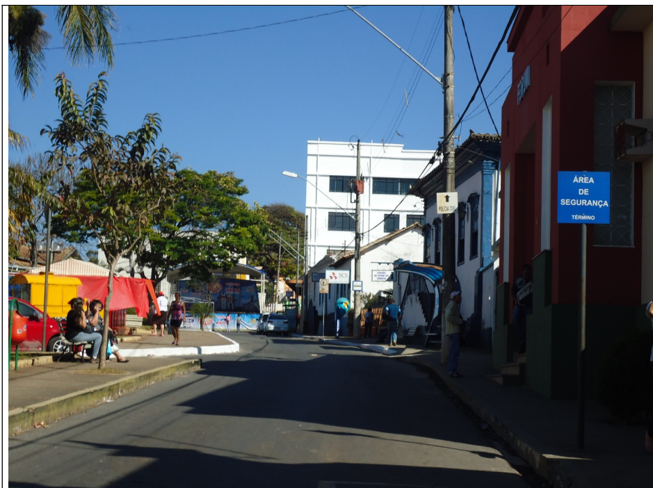
Figura 08 – Imagem de edificação existente na praça João Pinheiro contendo 4 pavimentos.
