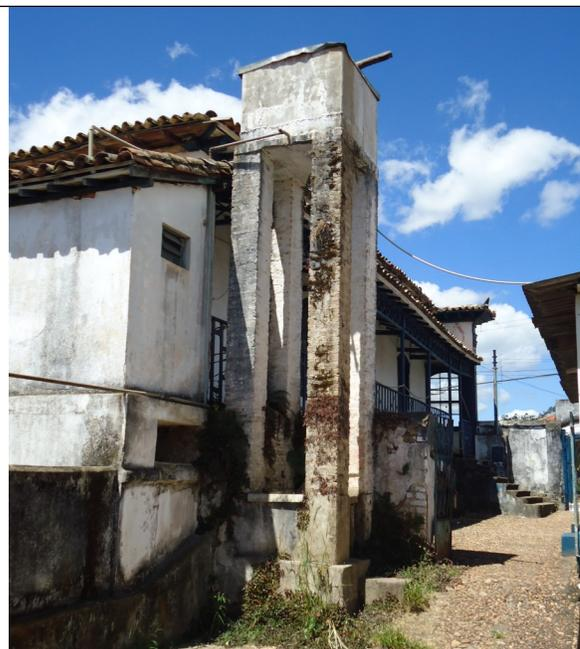
Figura 11 – Descaracterização com acréscimo do volume da caixa d'água e instalação sanitária.
