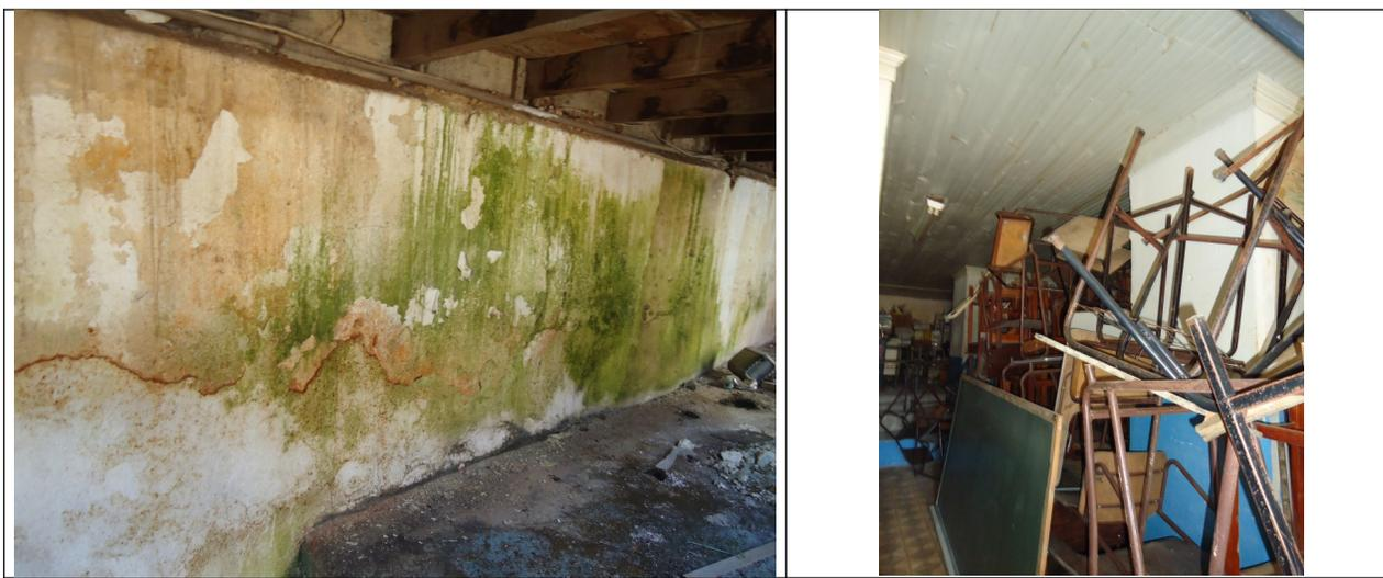
Figura 20 - Umidade junto à base da edificação.
