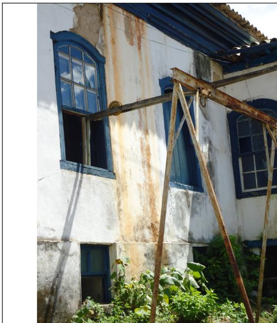
Figura 10 – Equipamento na lateral do imóvel, manchas de umidade e vegetação no terreno adjacente.
