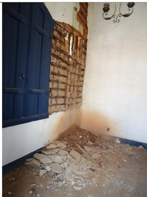
Figura 15 – Danos nas alvenarias.
