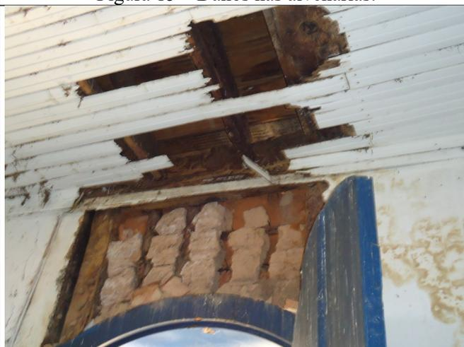
Figuras 16 e 17 – Danos no forro e alvenarias devido a presença de umidade.
