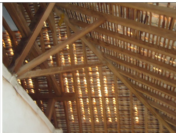
Figura 18 – Cobertura em bom estado de conservação.
