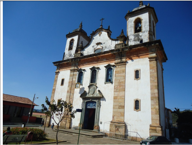
Figura 03 – Fachada frontal da edificação.
