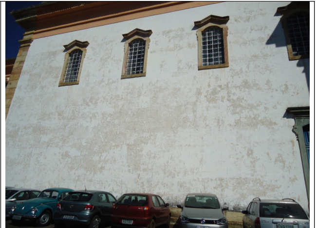
Figura 04 – Fachada lateral esquerda.
