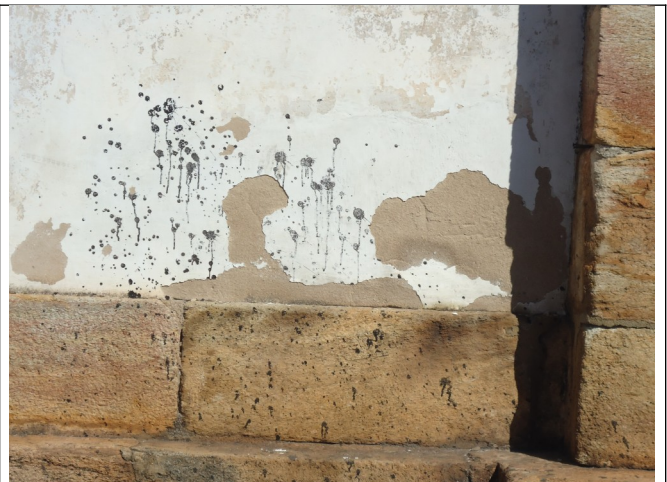
Figura 06 – Descolamento pintura.
