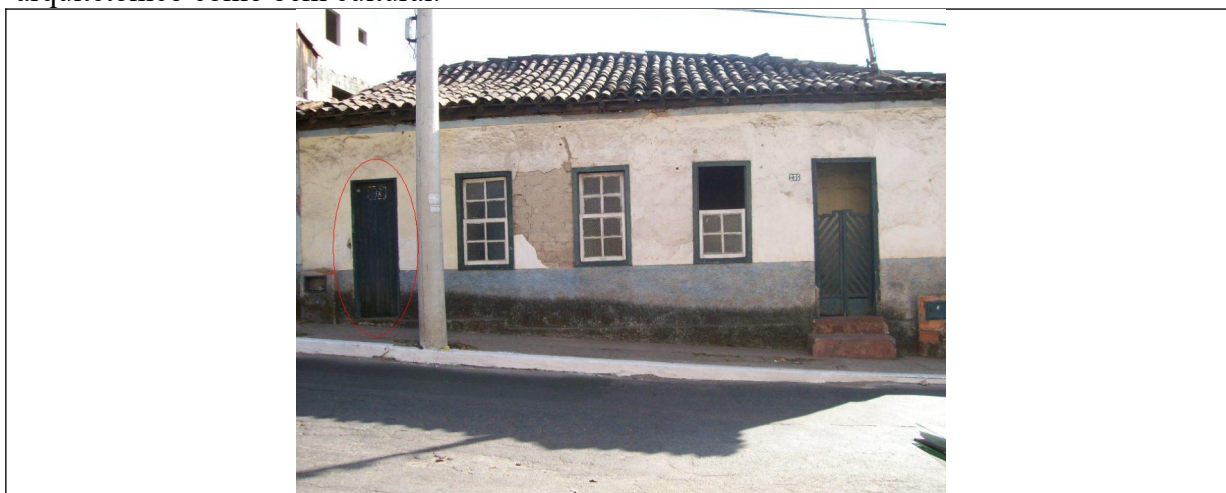
FIGURA 4 – Fachada principal do bem cultural: pode-se observar pequenas alterações devido ao uso cotidiano, contudo, não impede a leitura e compreensão do exemplar da arquitetura colonial.
