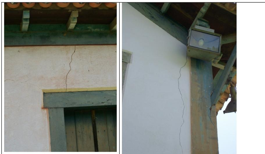
Figuras 05 e 06 – Trincas e fissuras.
