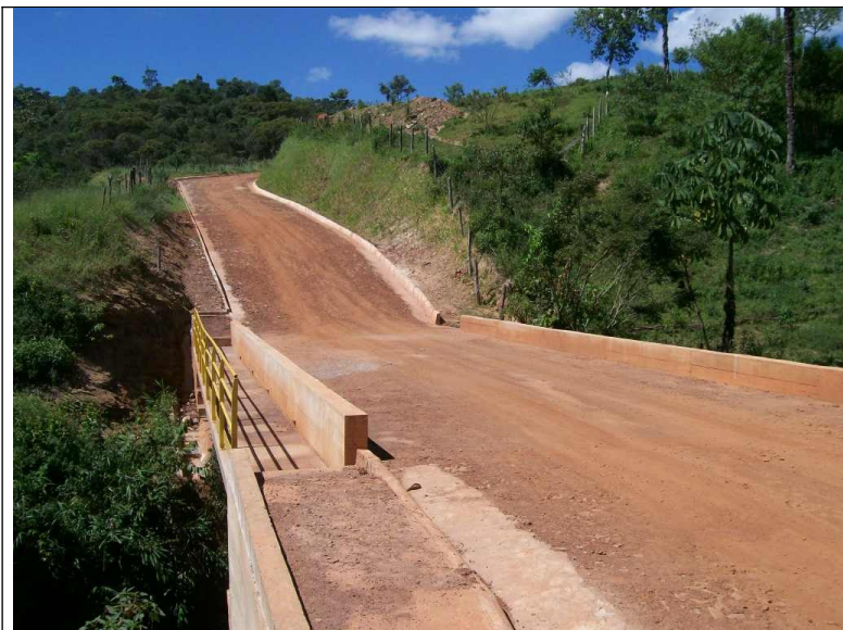
Figura 10 – Obra realizada com subida íngreme após a ponte.
