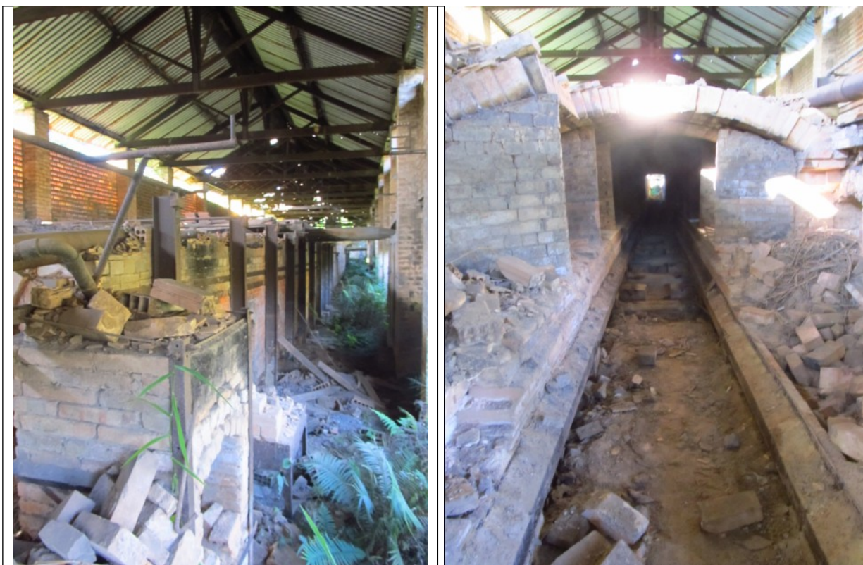
Figura 30 a 33 - Fotos internas da edificação nº 10. Fotos da vistoria.
