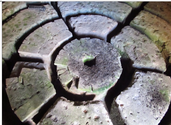
Figuras 53 e 54- Detalhe da cobertura em cúpula e do piso dos fornos existentes na Cerâmica João Pinheiro. Fotos da vistoria.
