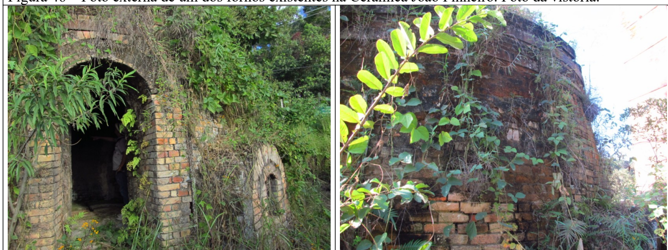
Figura 47 e 48- Fotos externas dos fornos existentes na Cerâmica João Pinheiro. Fotos da vistoria.
