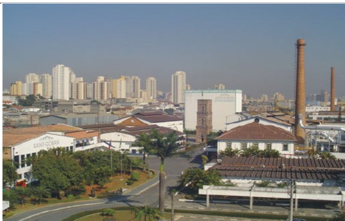
FIGURA 05 - Conjunto das edificações da Saint - Gobain, antiga Vidraria Santa Marina. Remanescentes tombados: Torre de energia; duas chaminés (fornos 5 e 20) e dois edifícios (Amazonas e São Paulo). Resolução de Tombamento 05/09. Fotografia: Angela Rösch Rodrigues, 2008.
