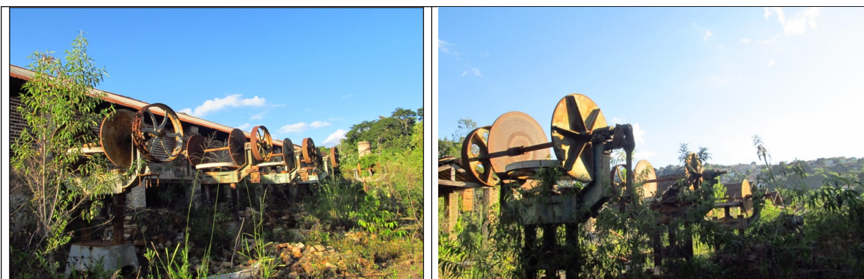
Figuras 34 e 35 - Equipamentos remanescentes da extinta Cerâmica São Pinheiro. Fotos da vistoria
