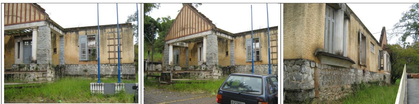
Figuras 05,06,07– Vista das fachadas do imóvel, sem a cobertura.
