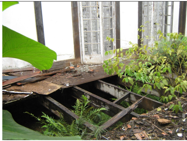
Figura 09 – Restos do piso de madeira e barrotes.
