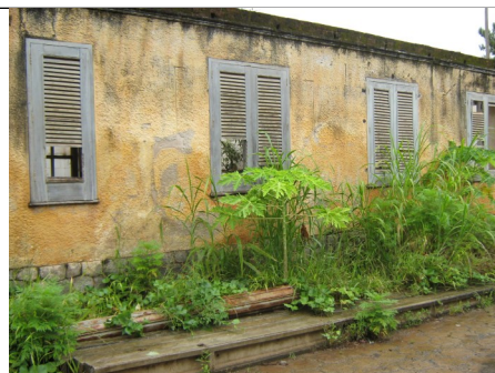
Figura 17 – Vegetação na área externa do imóvel.
