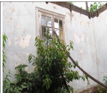
Figuras 33 a 35 – Crescimento de vegetação. Fonte: Vistoria realizada em 11/12/2012 pelo Setor Técnico desta Promotoria.
