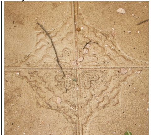
Figuras 30 a 32 – Pisos de ladrilhos hidráulicos. Fonte: Vistoria realizada em 11/12/2012 pelo Setor Técnico desta Promotoria.
