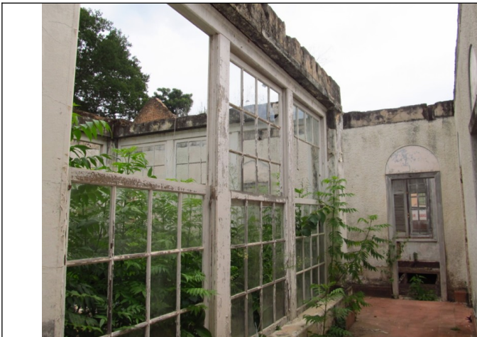
Figura 28 – Corredor e jardim interno. Fonte: Vistoria realizada em 11/12/12 pelo Setor Técnico desta Promotoria.
