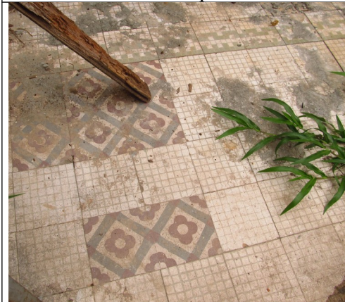
Figuras 30 a 32 – Pisos de ladrilhos hidráulicos. Fonte: Vistoria realizada em 11/12/2012 pelo Setor Técnico desta Promotoria.
