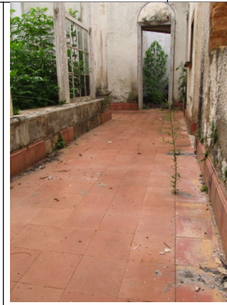
Figuras 30 a 32 – Pisos de ladrilhos hidráulicos. Fonte: Vistoria realizada em 11/12/2012 pelo Setor Técnico desta Promotoria.
