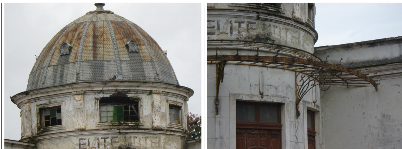
Figuras 13 e 14 – Cúpula e cobertura do acesso principal.
