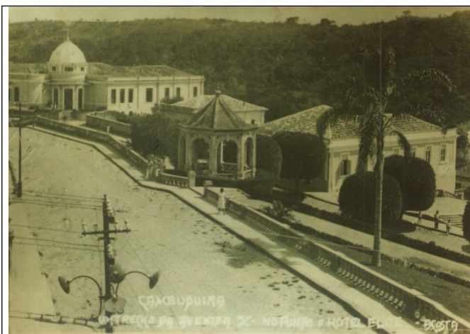
Figura 05 - Vista do Hotel Elite ao fundo.
