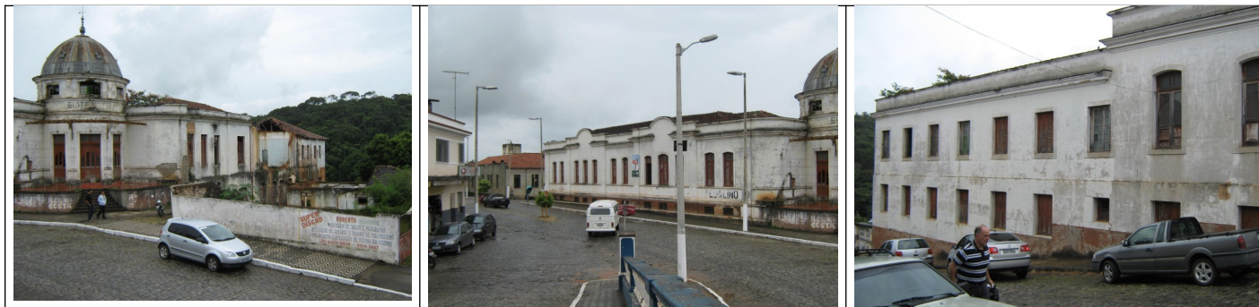
Figuras 20, 21 e 22 – Vistas gerais da edificação.
