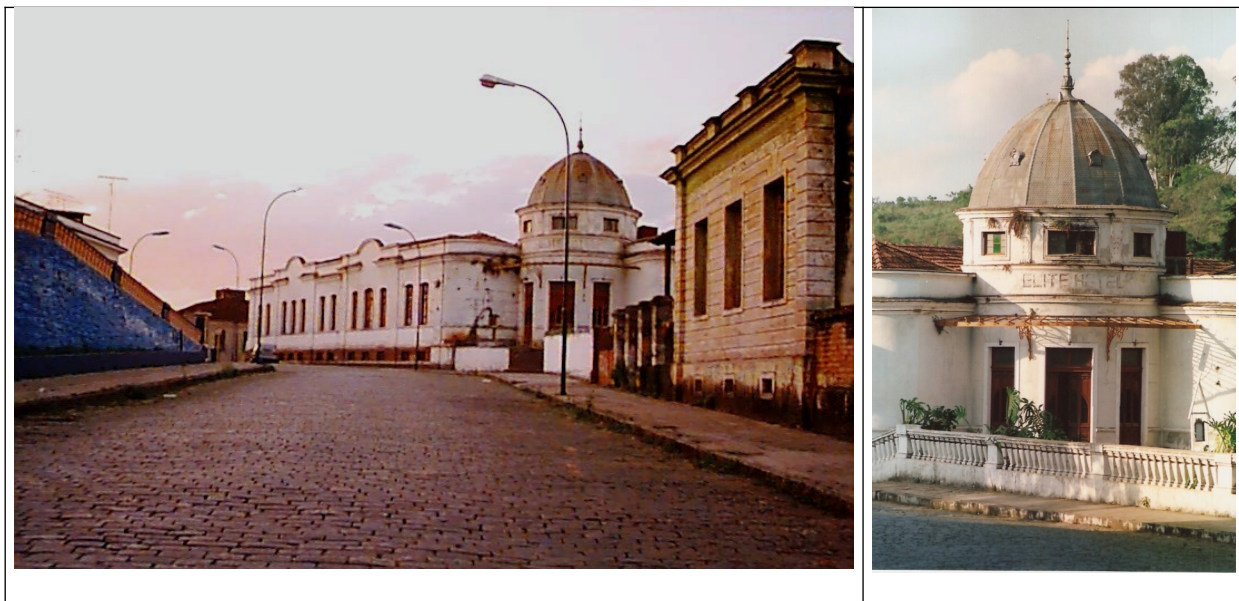
Figuras 07 e 08 – Imagens do Hotel Elite, quando se encontrava em regular estado de conservação.
