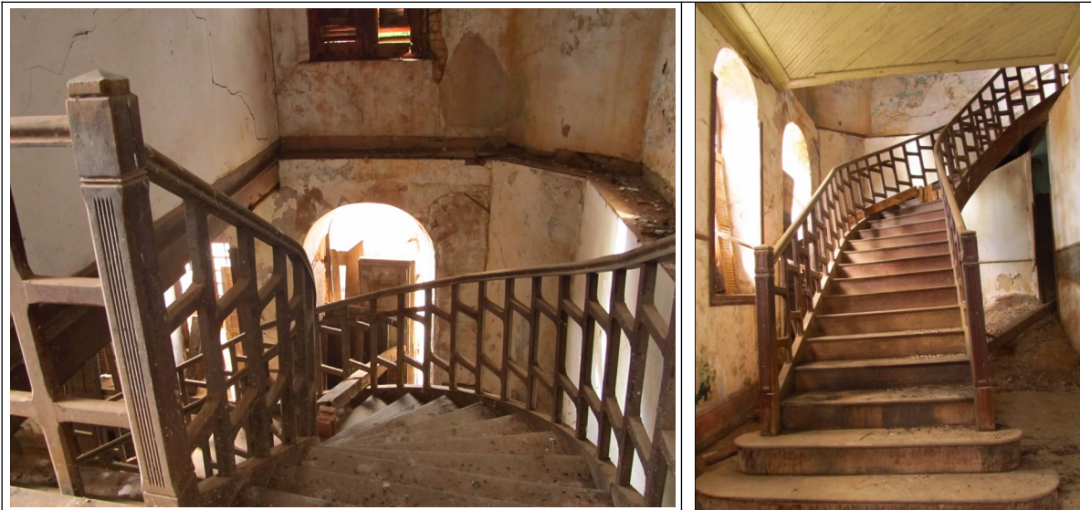
Figuras 40 e 41 – Escada que dá acesso ao antigo restaurante do Hotel Elite. Fonte: Vistoria 11 e 12 de dezembro de 2012 pelo Setor Técnico desta Promotoria.
