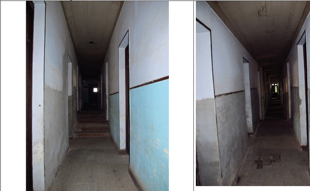
Figuras 42 e 43 – Extensos corredores existentes no Hotel Elite. Fonte: Vistoria 11 e 12 de dezembro de 2012 pelo Setor Técnico desta Promotoria.
