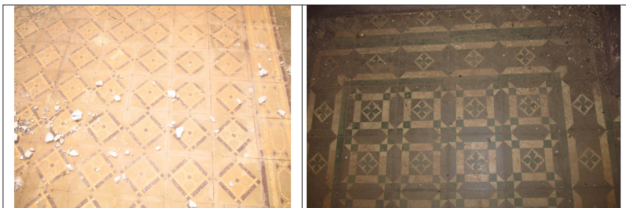
Figuras 34 e 35 – Ladrilhos no interior do Hotel Elite. Fonte: Vistoria 11 e 12 de dezembro de 2012 pelo Setor Técnico desta Promotoria.
