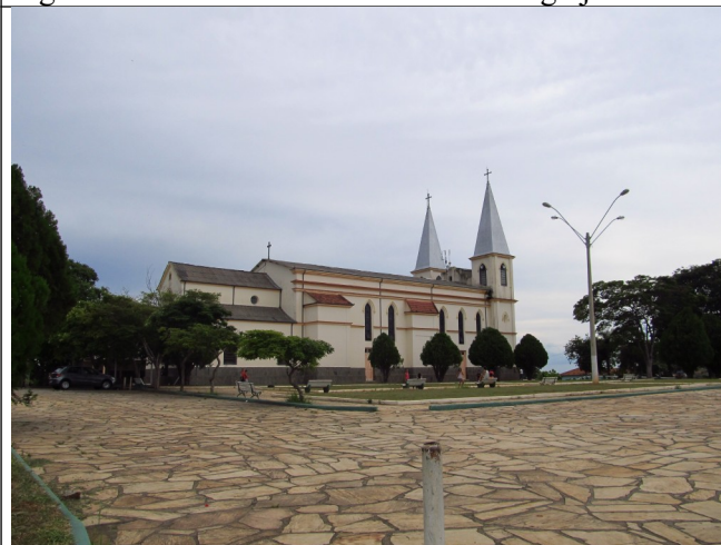
Figura 10 – Vista da fachada lateral.
