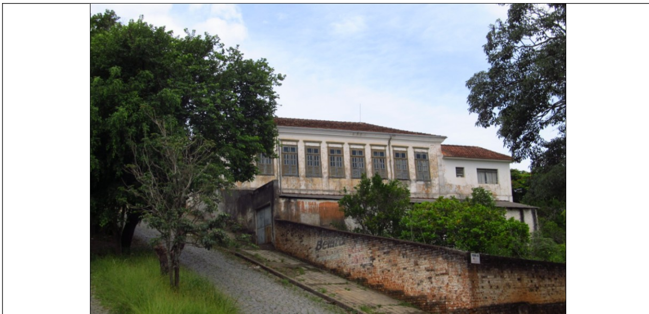
Figura 07 – Fachada dos fundos.
