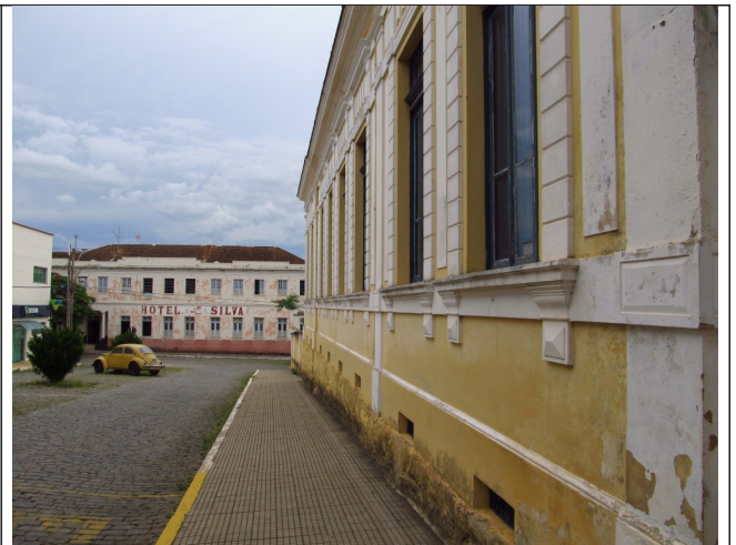
Figura 12 – Fachada lateral. Fonte: Vistoria realizada pelo Setor Técnico desta Promotoria.
