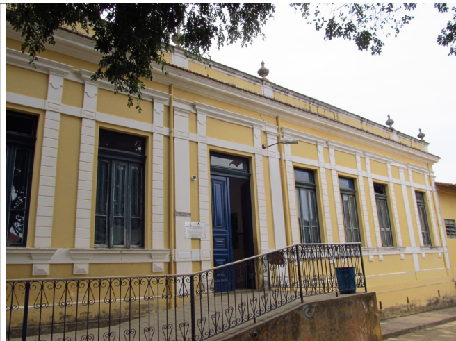
Figura 11 – Fachada lateral. Fonte: Vistoria realizada pelo Setor Técnico desta Promotoria.
