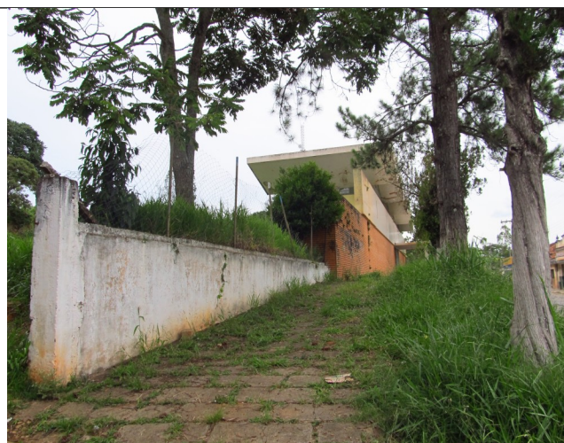
Figura 11 – Rampa de acesso ao edifício.
