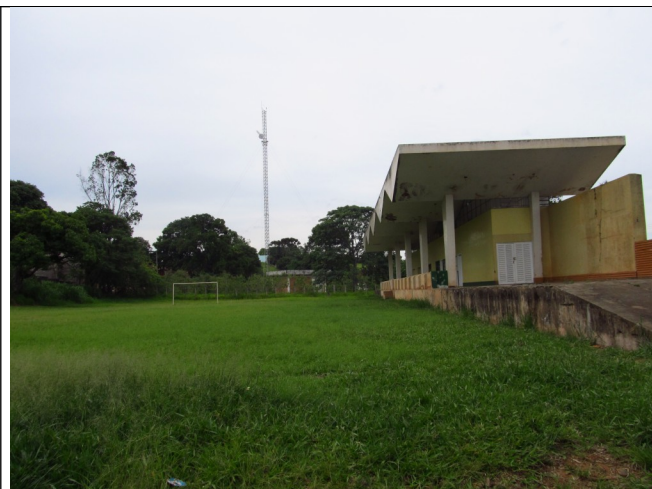
Figura 12 – Terreno aos fundos e parte posterior da Estação Ferroviária.
