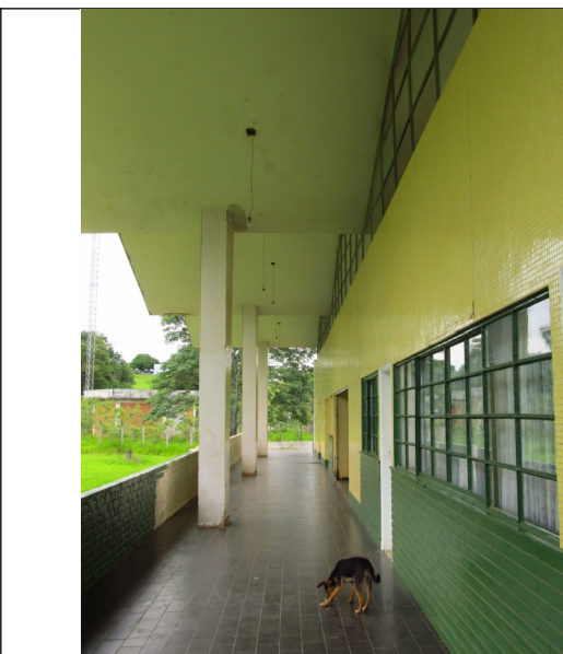
Figura 14 – Vista interna do edifício.
