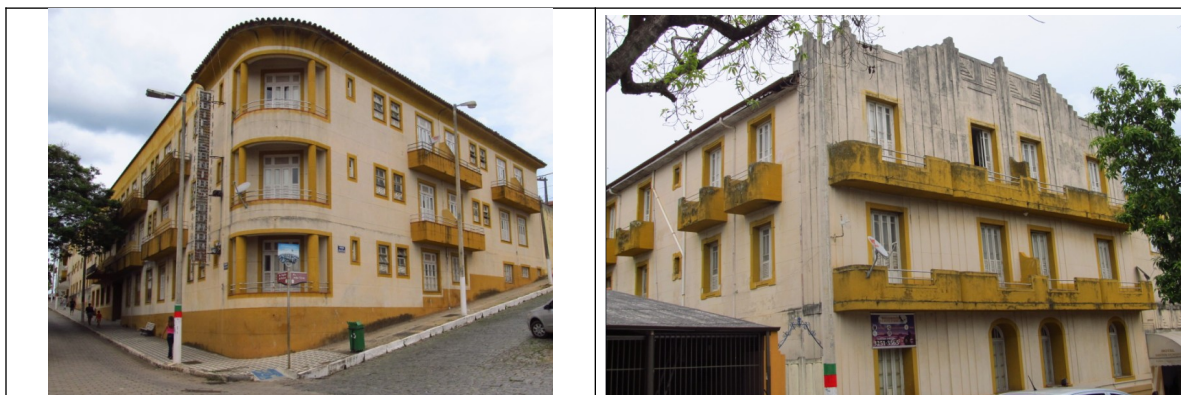
Figuras 02 e 03 - Hotel Santos Dumont. Fonte: vistoria realizada em 11/12/2012.
