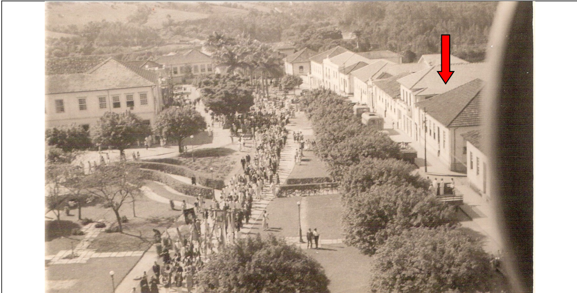
Figura 28 - Praça Dom Ferrão, procissão 1948. Imóvel em questão destacado pela seta vermelha.
