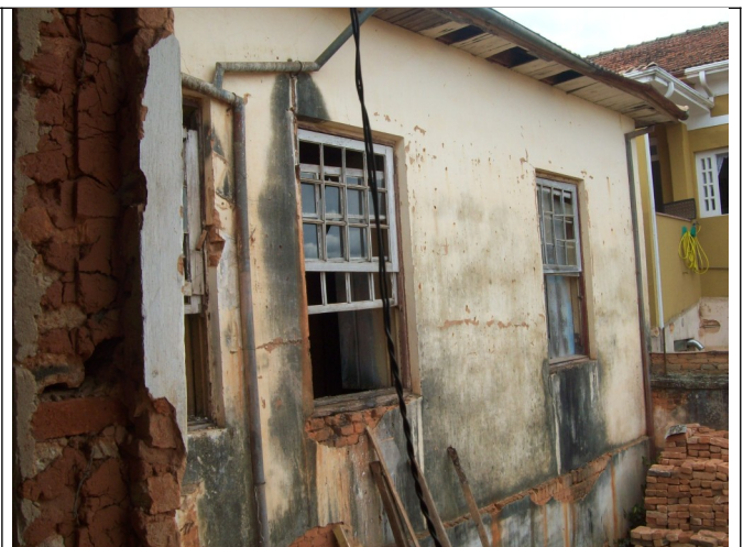
Figura 33 - Fachada de fundos
