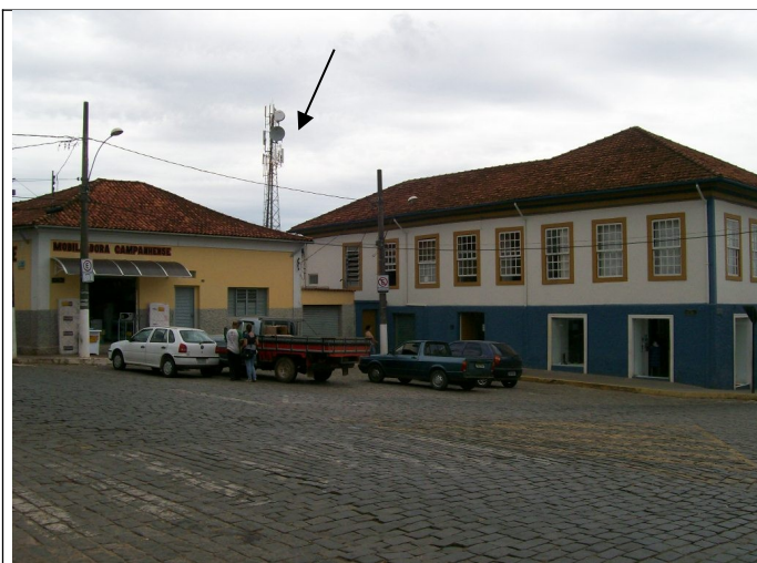
Figura 59 – Antena de telecomunicação no interior do núcleo histórico.
