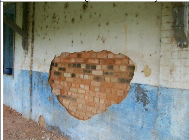
Figura 19 – Descolamento do reboco e sujidades nas alvenarias.
