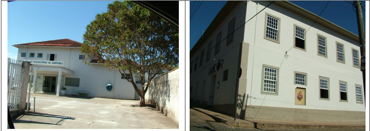
Figuras 05 e 06 – Figura com placa “Santa Casa de Misericórdia da Campanha”. Fotos cedidas pela equipe do IEPHA (vistoria realizada no dia 17 e 18 de junho de 2010).
