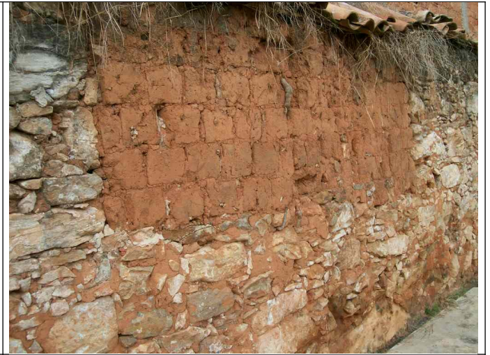
Figura 10 – Alvenaria de pedras e adobe.
