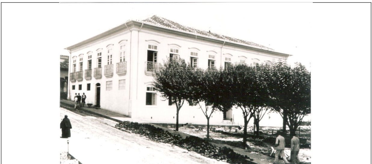
Figura 04 – Imagem antiga da edificação.
