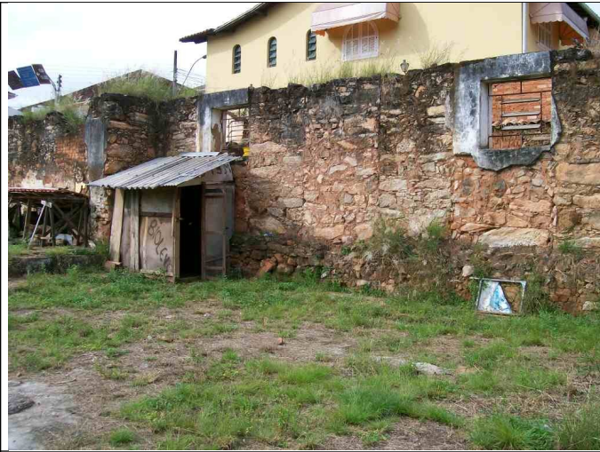
Figura 09 – Vista da área interna.
