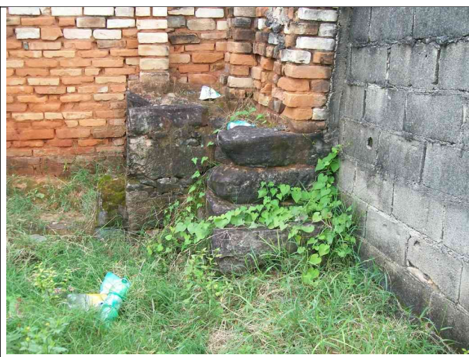
Figura 08 – Remanescente de pedras do cunhal, junto a alvenarias de tijolos contemporâneas.
