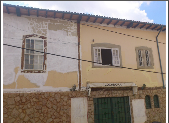
Figura 08 – Vãos e esquadrias alterados.
