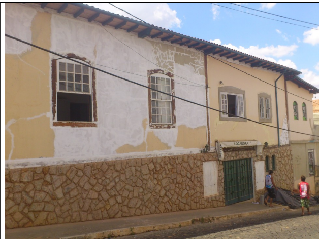
Figuras 09 e 10 – Fachada lateral direita, contendo os vãos e esquadrias alterados.
