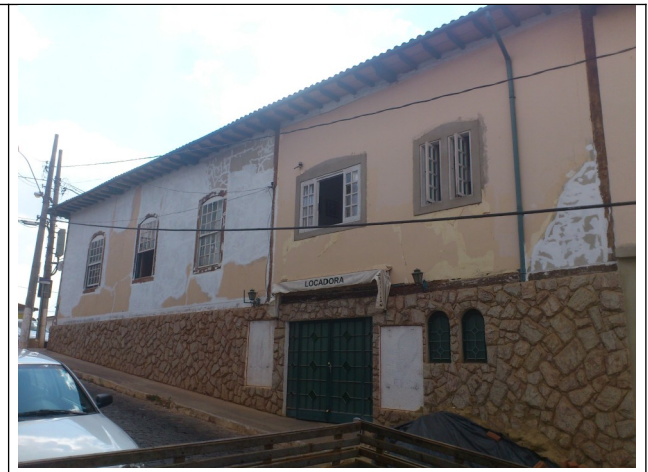
Figuras 09 e 10 – Fachada lateral direita, contendo os vãos e esquadrias alterados.
