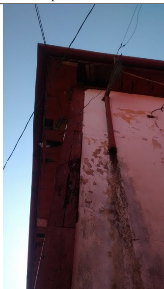
Figura 16 – Detalhe da drenagem pluvial e telhado
