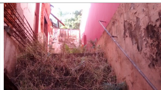
Figura 4 – Escada lateral tomada de vegetação.
