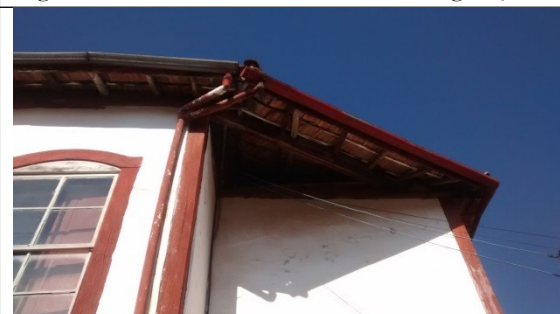
Figura 6 – Detalhe do telhado
