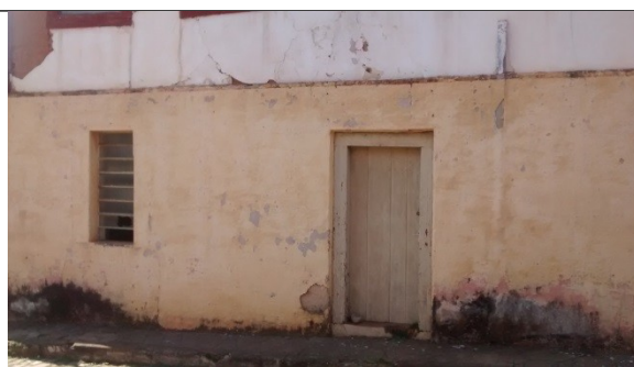
Figura 11 – Detalhe dos vãos do porão
