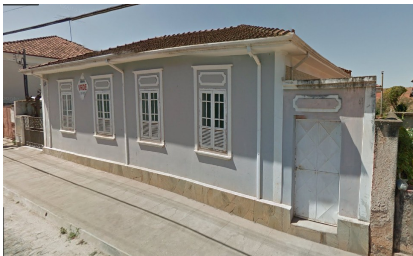
Figura 04 - Fachada do imóvel antes das obras de intervenção.
