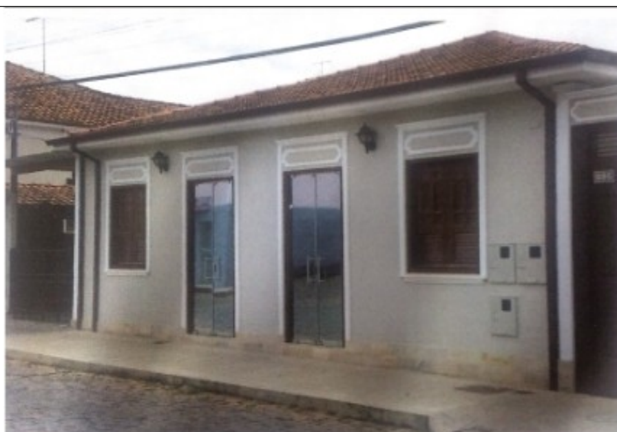
Figura 05 – Fachada da edificação após o término das obras. Foto de 9 de março de 2018.
