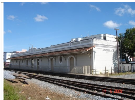
Figura 02 – Estação Ferroviária de Campo Belo e pátio de manobras.
