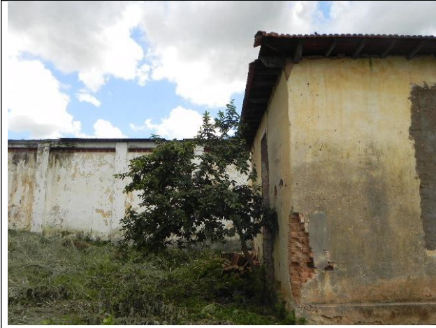
Figura 10 – Reboco danificado.
