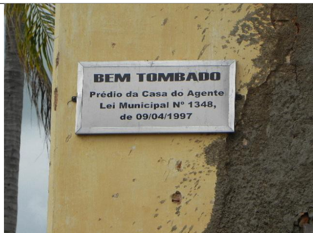
Figura 07 – Placa afixada na alvenaria do bem.
