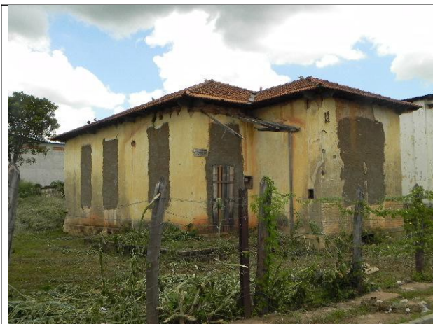
Figura 06 – Vista da edificação.
