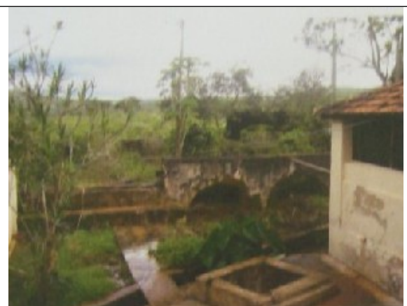
Figura 12- Imagem de um aqueduto construído por escravos numa fazenda da área rural de Campos Altos. Fonte: Plano de Inventário pesquisado junto ao IEPHA.
