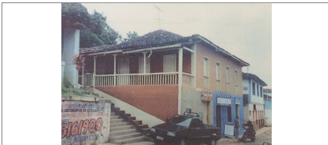
Figura 03- Imagem do imóvel, sem data. Fonte: Ficha de Inventário do imóvel.
