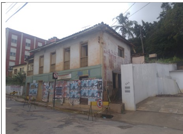
Figura 1 – Vista da fachada frontal da edificação da Rua das Flores nº 550/544/548
