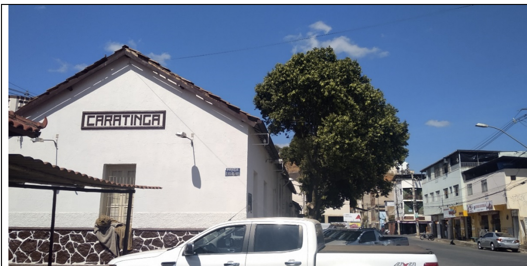
Figura 04 – Prédio da Estação Ferroviária de Caratinga. Fonte: Laudo do estado de conservação de 2019.
