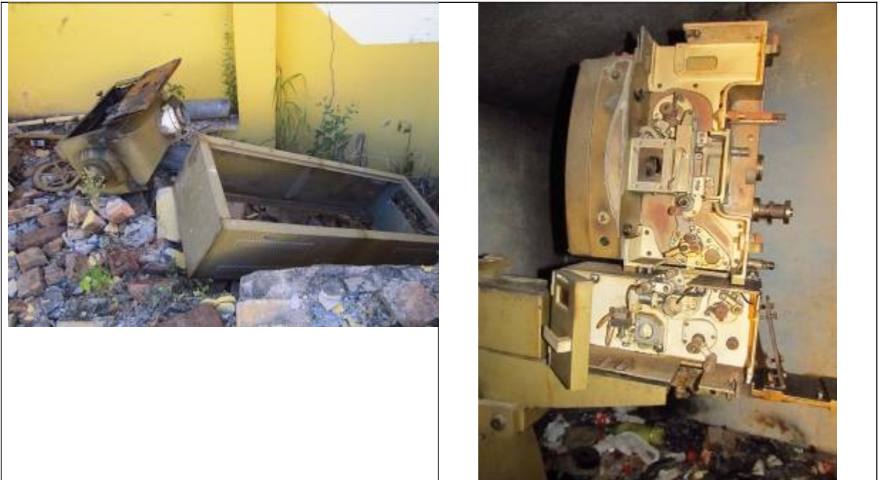
Figuras 20, 21, 22, 23, 24 e 25- Vestígios do antigo cinema. Fotos da vistoria realizada em 21.01.2015.
