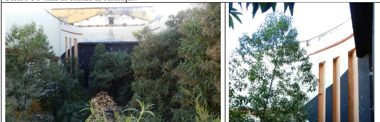
Foto 7- Vegetação no interior da edificação.
