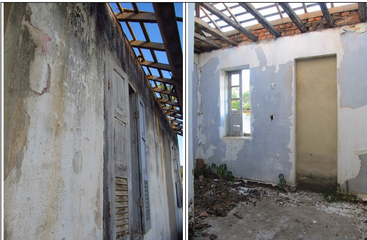
Fotos 12 e 13- Anexo residencial localizado nos fundos do antigo Cine Brasil
