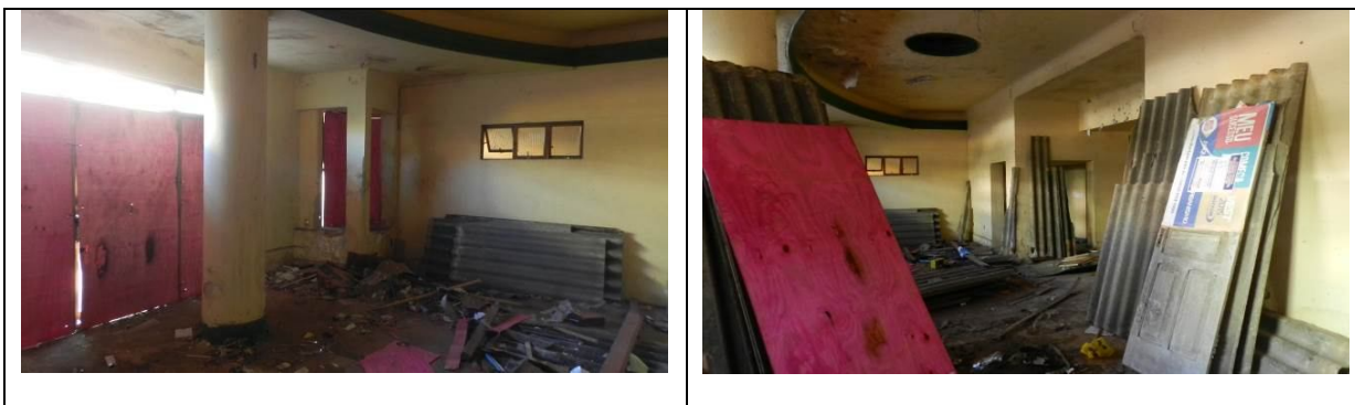
Fotos 5 e 6- Hall de entrada da edificação.
