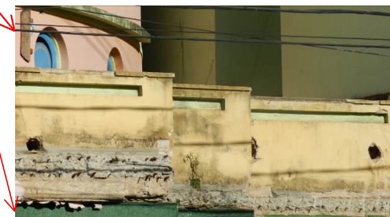
Fotos 3 e 4- Detalhe Foto 1. Observar frisos horizontais na fachada principal. Notar local da existência de uma marquise.
