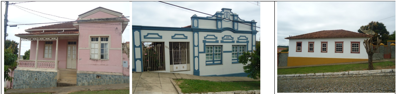
Figuras 20 a 22 – Algumas das edificações inventariadas na Avenida Dom Alexandre Amaral.
