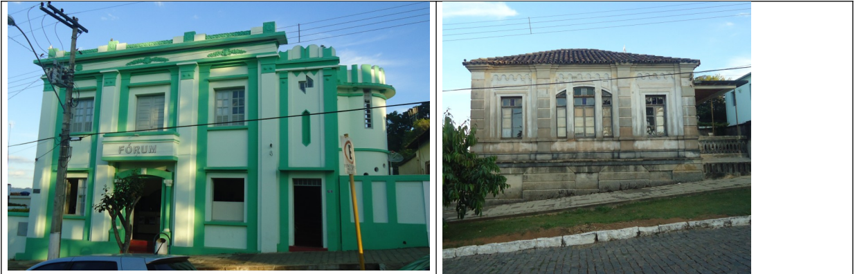
Figuras 09 e 10 – Algumas das edificações inventariadas na Praça Joaquim Afonso Rodrigues.
