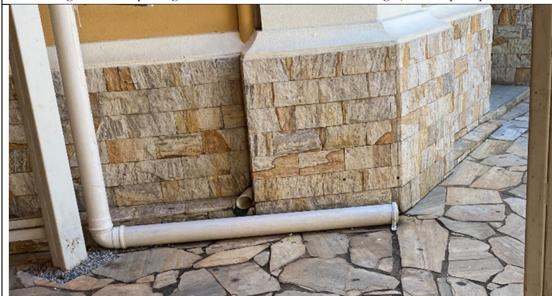
Figura 02 – Lançamento de águas pluviais junto a base da edificação.
