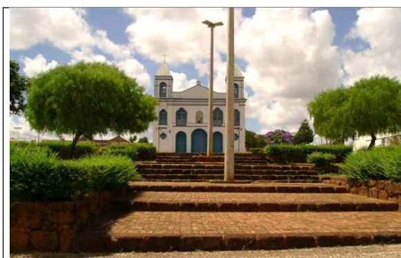
Os dois postes instalados em frente a Igreja Matriz Nossa Senhora do Carmo
