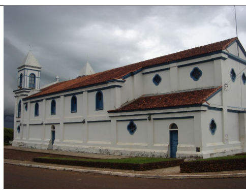
Lateral direita da Igreja Matriz de Nossa Senhora do Carmo
