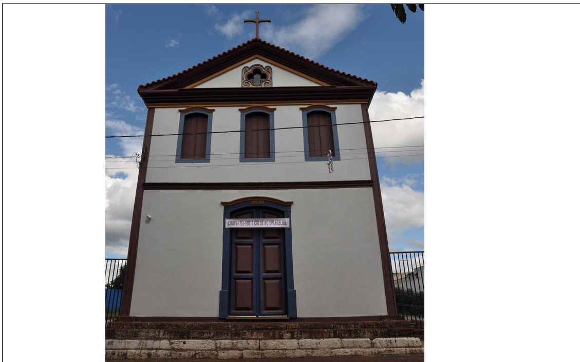
Figura 01 – Fachada frontal da Igreja de Nossa Senhora do Rosário. Fonte: COMPAC 2020
