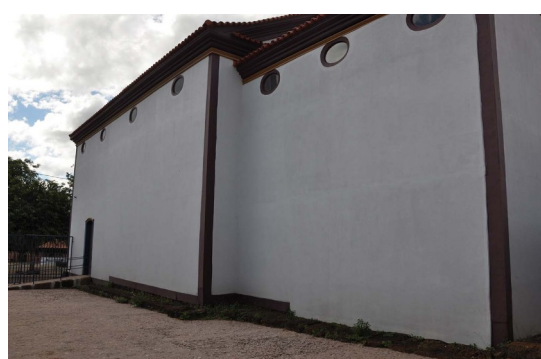
Figura 05 – Fachada lateral da Igreja de Nossa Senhora do Rosário. Fonte: COMPAC 2020
