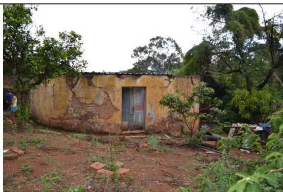
Figura 05 – Imagem geral da caixa d'água.
