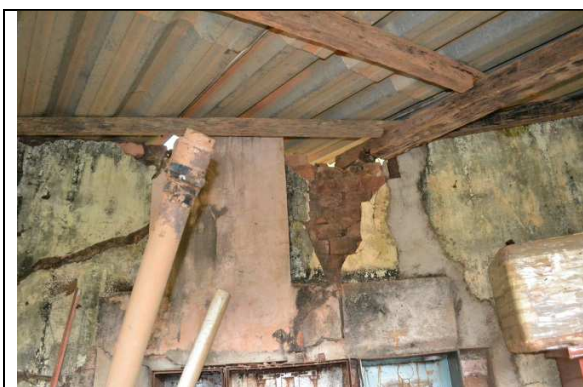
Figura 10 – Cobertura provisória.
