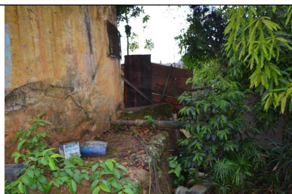
Figura 11 – Base de pedras .
