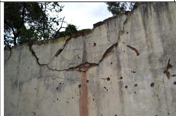
Figuras 06 e 07 – Sérios comprometimentos estruturais denunciados pelas trincas, fissuras, descolamento do reboco.
