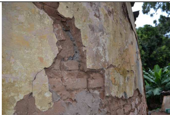
Figuras 06 e 07 – Sérios comprometimentos estruturais denunciados pelas trincas, fissuras, descolamento do reboco.
