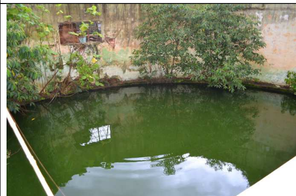
Figura 08 – Água no interior do reservatório.
