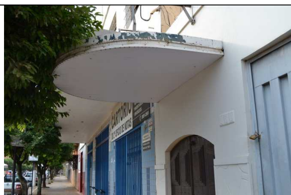
Figura 09 – Detalhe no primeiro pavimento.
