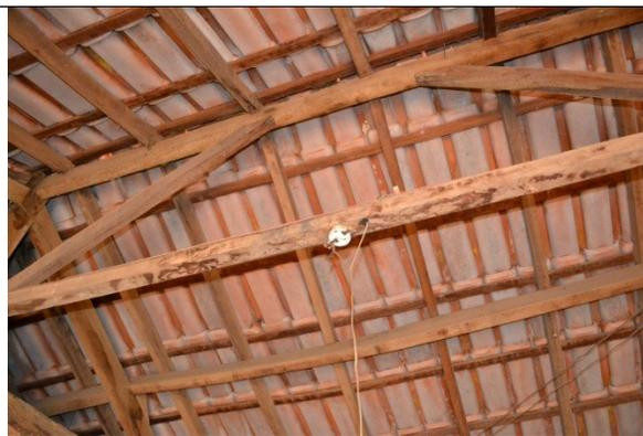
Figura 07 – Telhado em bom estado de conservação.
