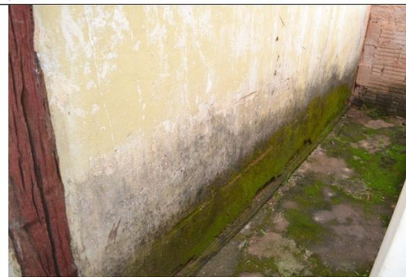
Figura 09 – Manchas de umidade junto a base.
