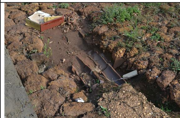
Figura 05 – Tubulação no leito da via, erosão e lixo no local.
