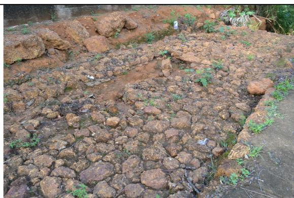
Figura 10 – Pedras soltas e erosão no leito da via.
