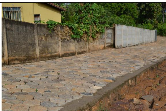
Figura 04 – Pavimentação em blocos sextavados de concreto, que se encontram instáveis e comprometem a ambiência.
