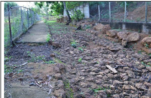
Figura 13 – Descontinuidade da calçada, erosão no leito da via, pedras soltas.
