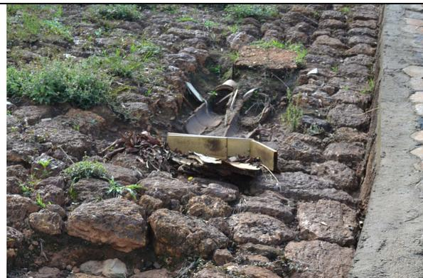
Figura 07 – Tubulação no leito da via, erosão e lixo no local.
