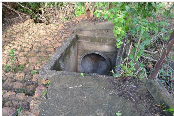
Figura 12 – Manilha sem proteção.
