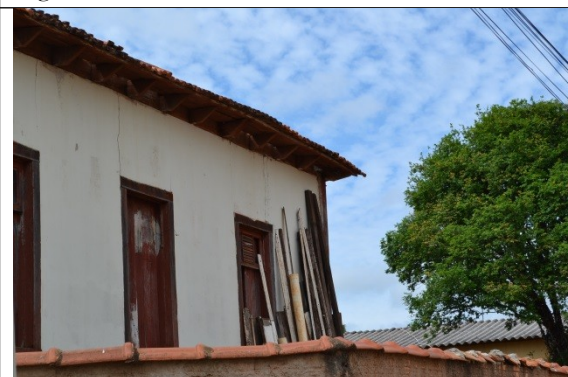
Figuras 08 e 09 – Danos nas alvenarias e madeiras expostas ao tempo.
