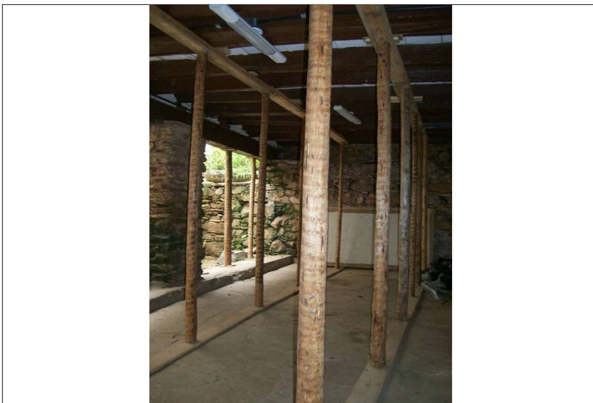
Figura 10 – Esquema para escoramento das peças de madeira do telhado, do piso (através do porão) e das varandas.
