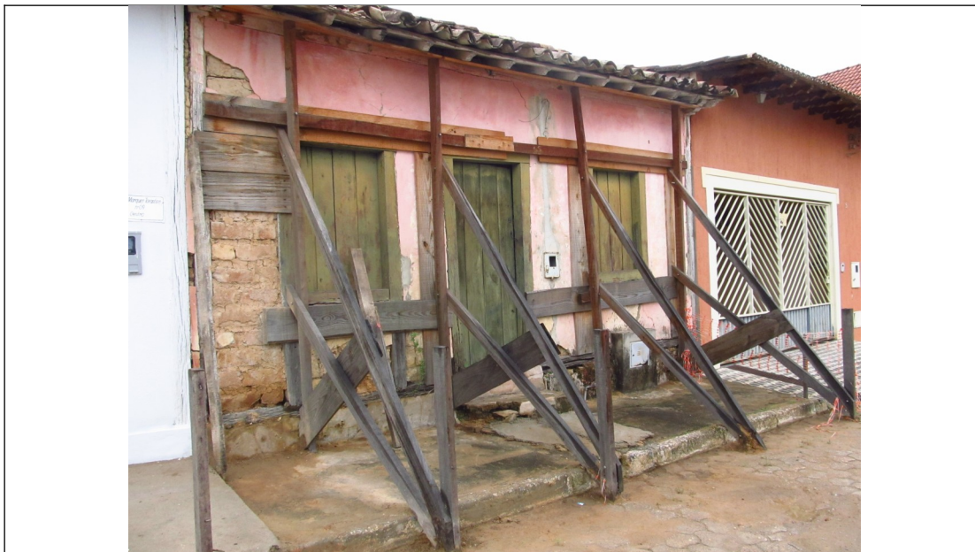
Figura 09 – Imagem de escoramento de fachadas. Fonte: Setor Técnico Promotoria Estadual de Defesa do patrimônio Cultural e Turístico de MG.
