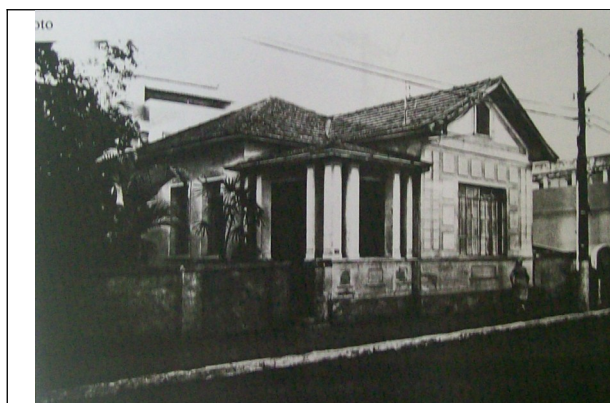
Figura 16 – Imóvel edificado na Praça Senhor dos Passos, nº 38.
