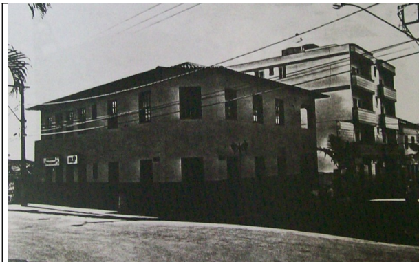
Figura 10 – Imóvel edificado na Praça Nossa Senhora do Carmo, nº 3, 5 e 7. Fonte: Preservação do Patrimônio Cultural – pareceres, exercício 2002.
