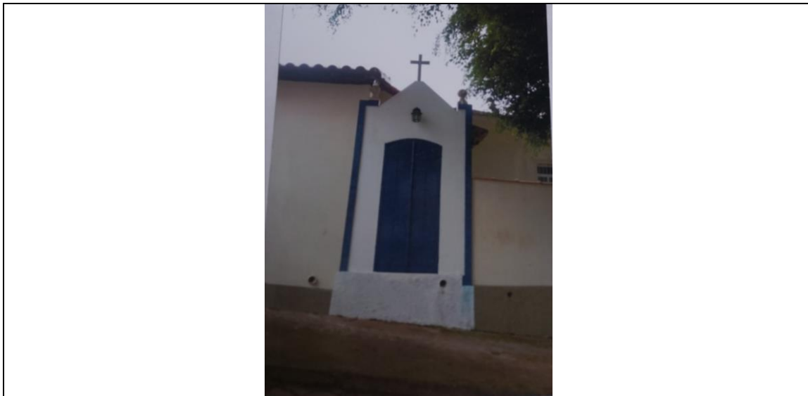
Figura 06 – Nota-se que a obra do imóvel adjacente já havia sido finalizada.
