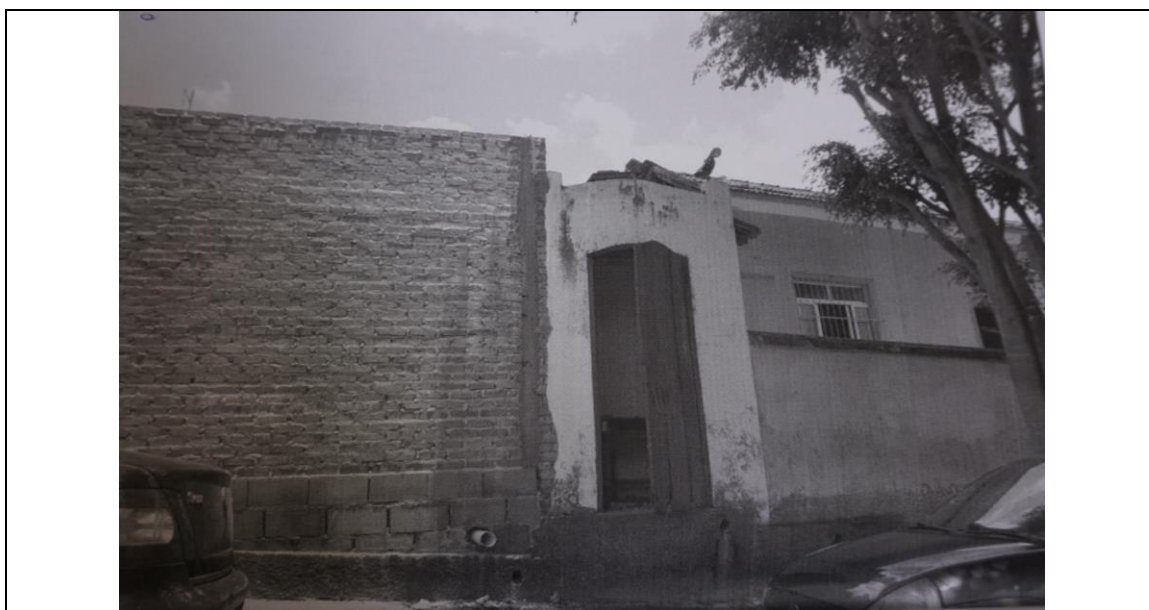
Figura 05 – Registro da construção que avança em direção ao Passo edificado na Rua Padre Tolêdo. Fonte: Sr. Lucas Souza, janeiro de 2017.
