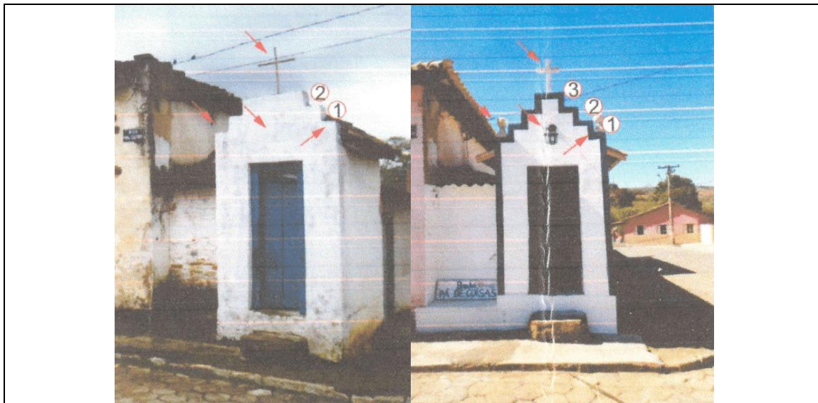
Figura 10 – Em evidência estão as intervenções feitas no bem, destacadas pelo denunciante, fotos de 2014 e 2017. Fonte: Sr. Lucas Souza.
