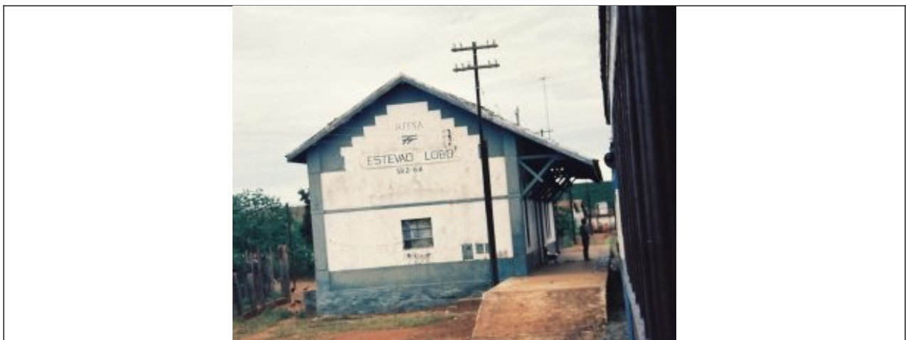
Figura 04 – Estação Ferroviária de Estevão Lobo. Verifica-se
