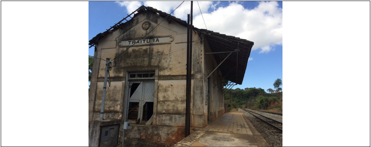
Figura 07 – Registro fotográfico da estação no ano de 2015.
