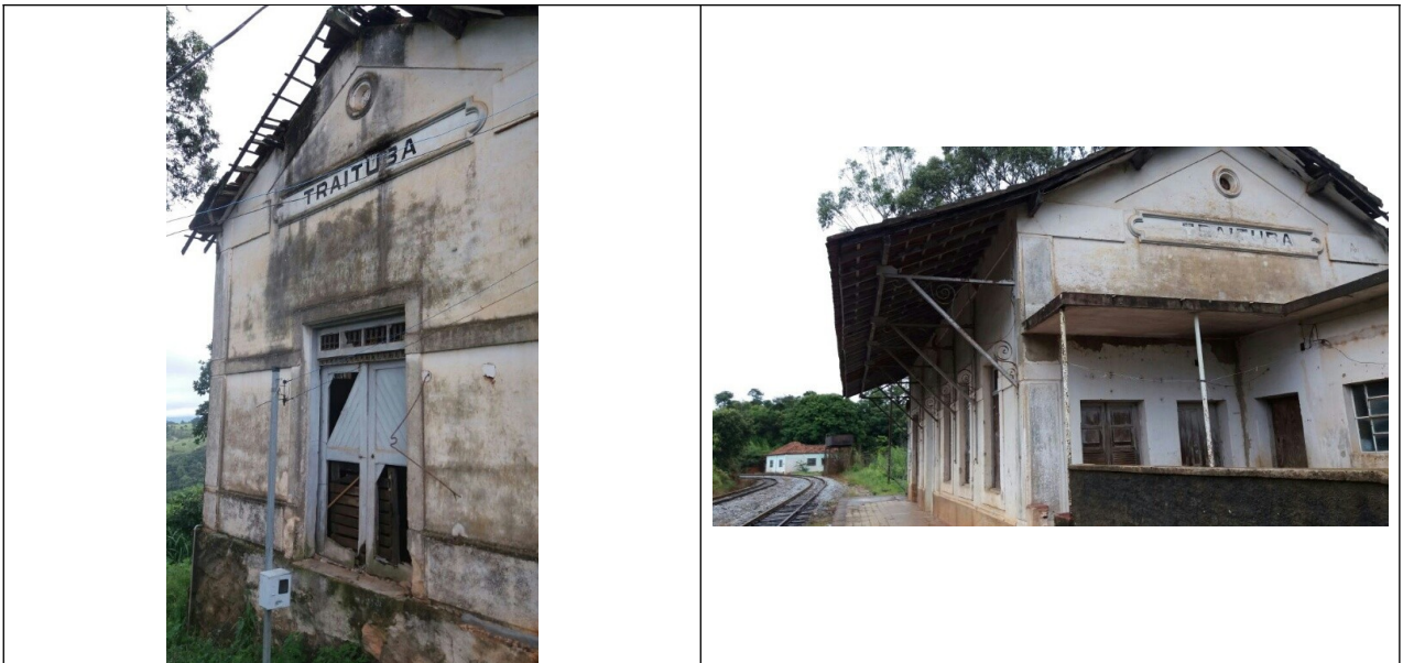
Figuras 08 e 09 – Registros fotográficos da estação no ano de 2016. Fonte: CPPC.
