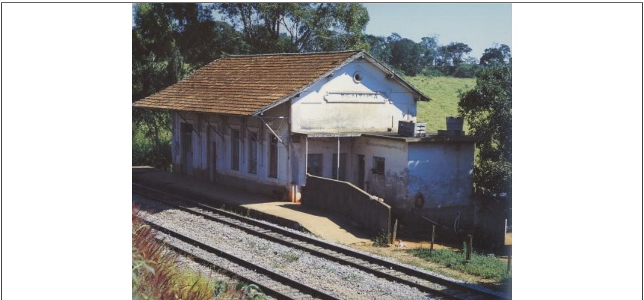
Figura 06 – Registro fotográfico da estação no ano de 2005.
