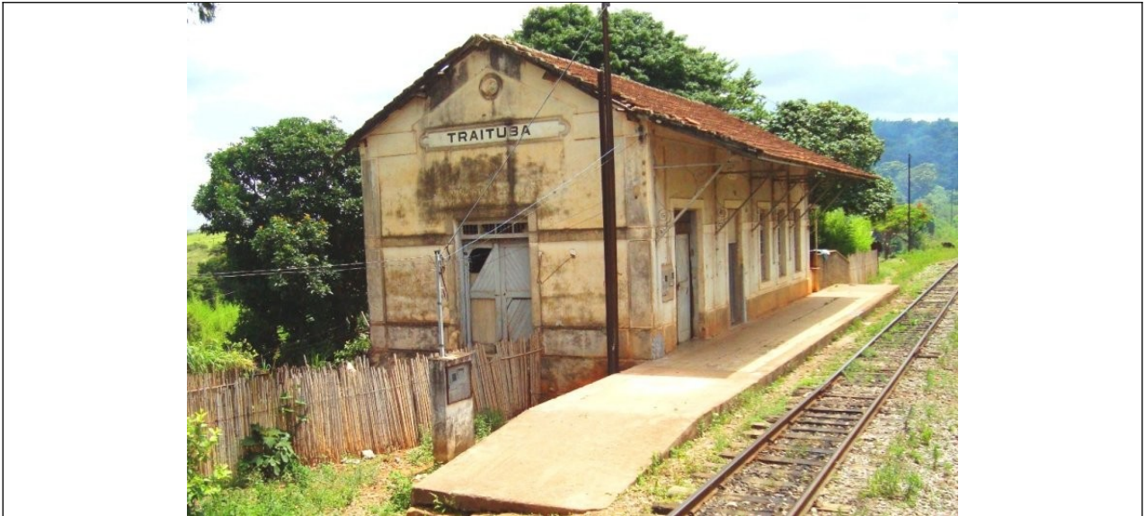
Figura 05 – Registro fotográfico da estação no ano de 2001.
