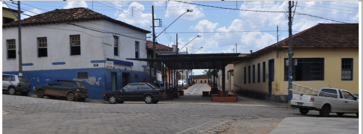
Figura 08 – Vista geral do local após a intervenção. Verifica-se que houve sombreamento das fachadas dos imóveis lindeiros, causando prejuízo à iluminação e ventilação dos imóveis adjacentes, cuja visibilidade também ficou prejudicada.
