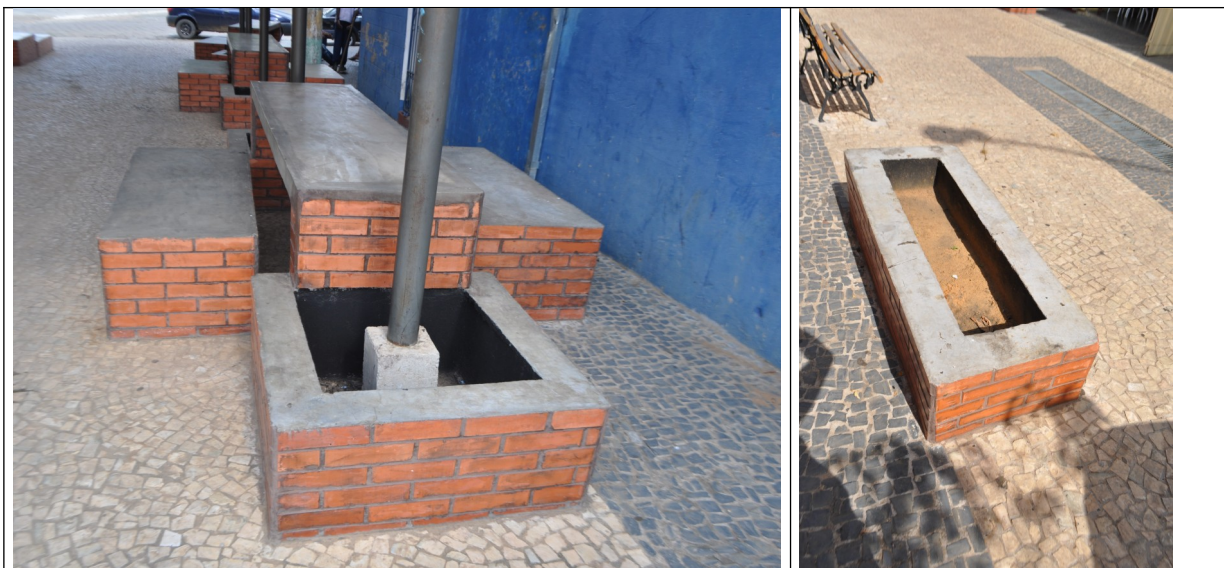
Figura 16 e 17 – Detalhe do mobiliário fixo e canteiros sem plantio de vegetação.
