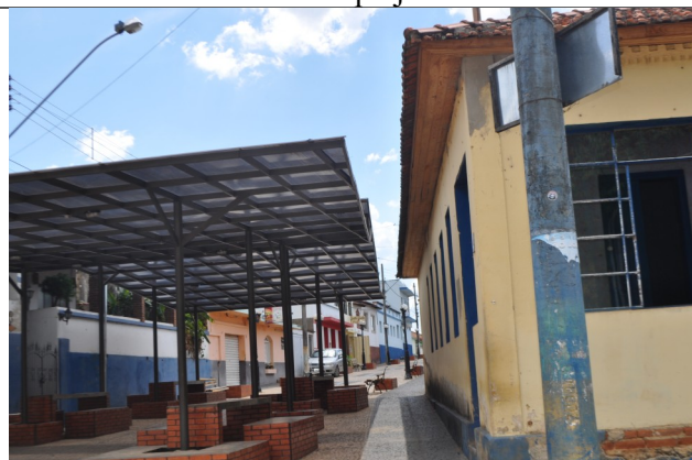
Figura 09 – Imagem da cobertura e do mobiliário fixo existente, bastante próximo de uma edificação residencial.
