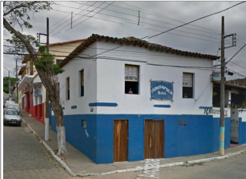
Figura 06 – Imagem do ano de 2011 da edificação mais antiga da rua.
