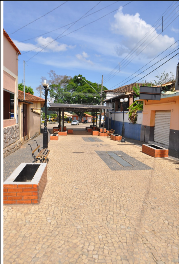
Figura 12 – Vista geral do trecho descoberto do calçamento. Não há lixeiras e não foi feito plantio de vegetação nos canteiros.
