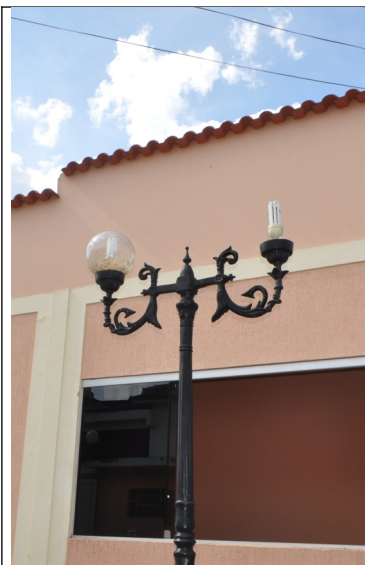
Figura 13 – Luminária danificada.
