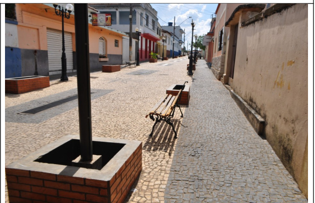
Figura 10 – Vista geral do trecho descoberto do calçamento. Não há lixeiras e não foi feito plantio de vegetação nos canteiros.
