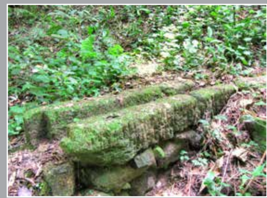
Foto 22 – Para manter o nivelamento, a canalização recebia preenchimento de apoio com pedras em juntas secas, mostrando o conhecimento técnico de seus construtores. Foto: Emile Scharlé Jr., 2014.
