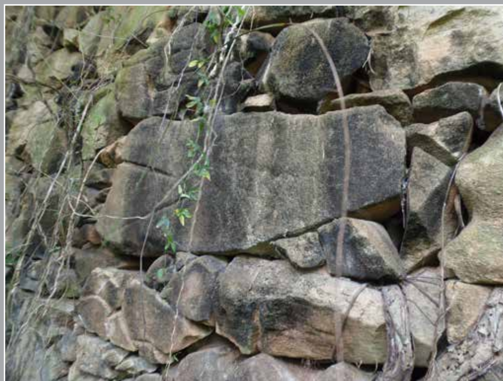
Foto 33 - Detalhe do sistema construtivo composto por pedras sobreposta em junta seca. Foto: Henrique Piló, 2014.
