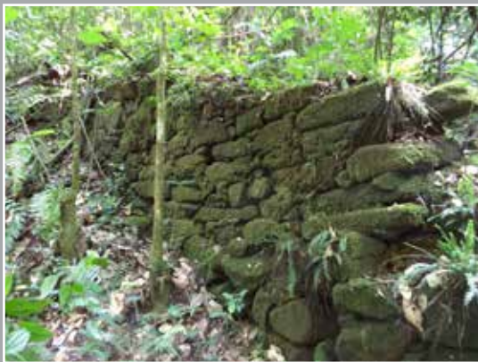
Foto 18 – Detalhe de muro de arrimo para que a canalização mantivesse a declividade ideal em trecho íngreme. Foto: Henrique Piló, 2014.
