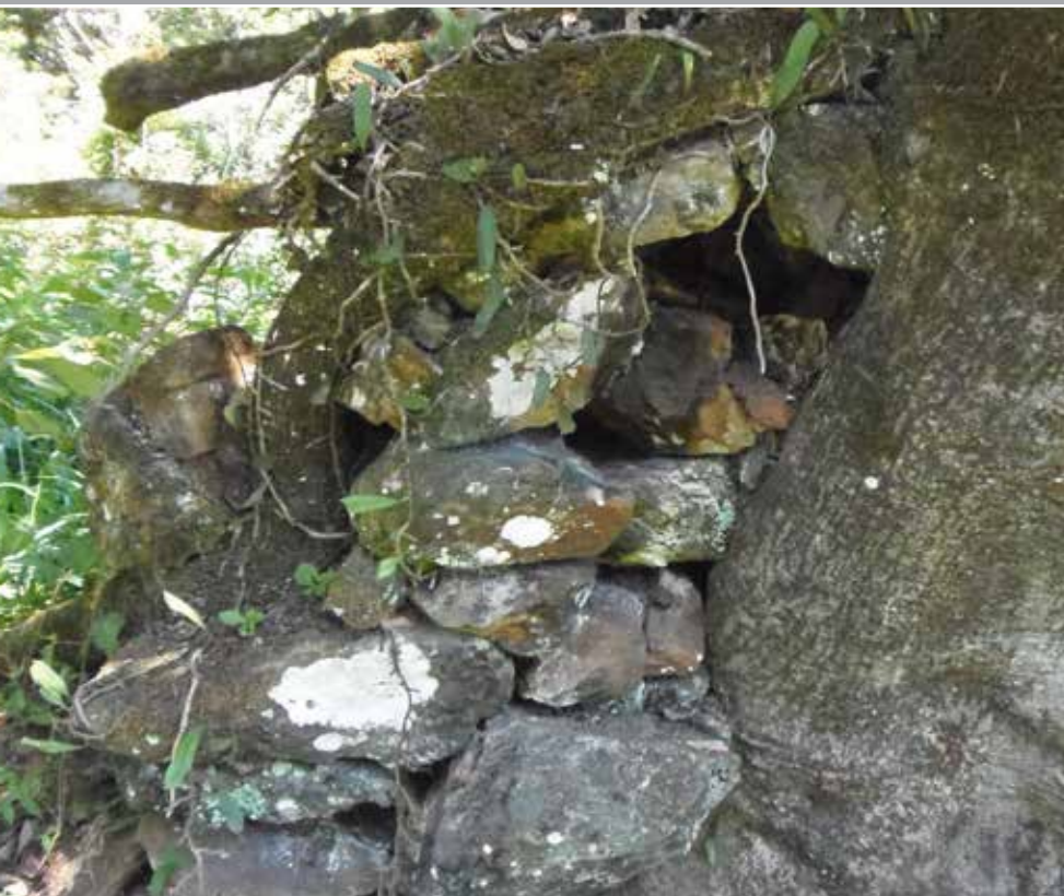
Foto 37 – Detalhe do sistema construtivo em pedras secas. Foto: Henrique Piló, 2014.
