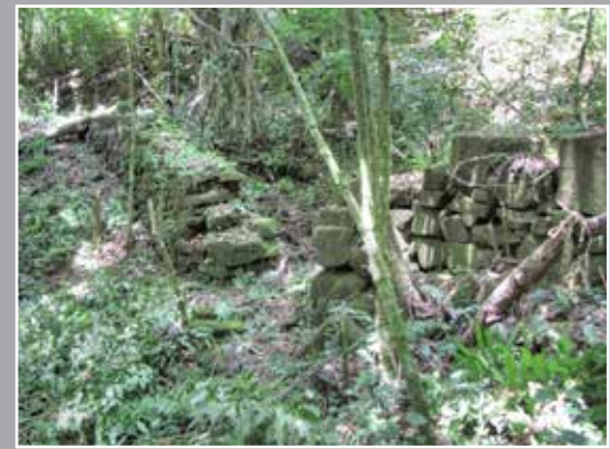
Foto 21 – Trecho onde possivelmente arcos transpunham trechos maiores sobre pequenas depressões do terreno natural. Foto: Emile Scharlé Jr., 2014.
