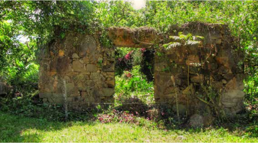
Vista de ruína em alto maranhão. Foto Emile Scharlé Jr.
