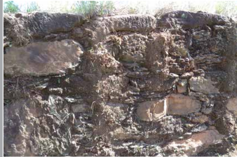
Foto 54 – Detalhe do sistema construtivo: pedras de grandes dimensões embrechadas com menores. Foto: Henrique Piló – janeiro de 2014
