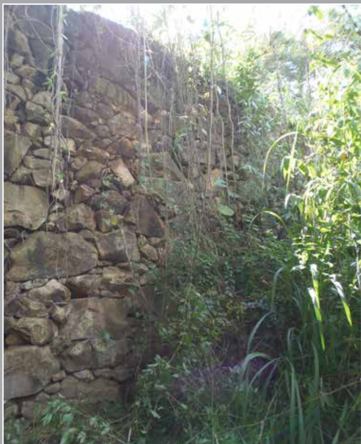
Foto 32 – Outro trecho do muro em bom estado de conservação. Foto: Henrique Piló, 2014.
