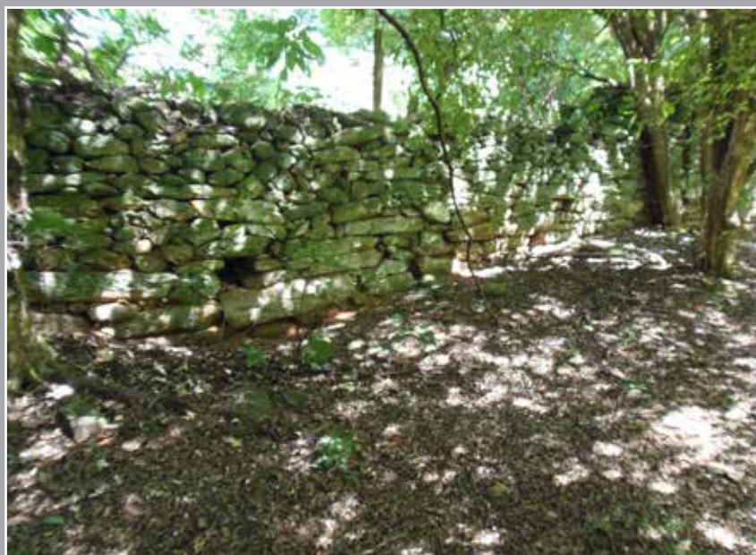
Foto 38 -Um dos trechos do muro ainda intacto. Foto: Henrique Piló, 2014.
