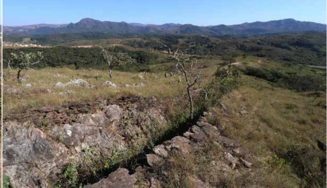
Foto 05 – Vista de canal com escoro em pedras na região do Tijucal. Foto: Lucas Nishimoto, 2014.
