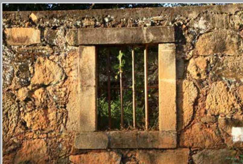
Foto 5 – Detalhe da janela frontal com enquadramento em singelo trabalho de cantaria. Foto: Helio Martins, 2014.
