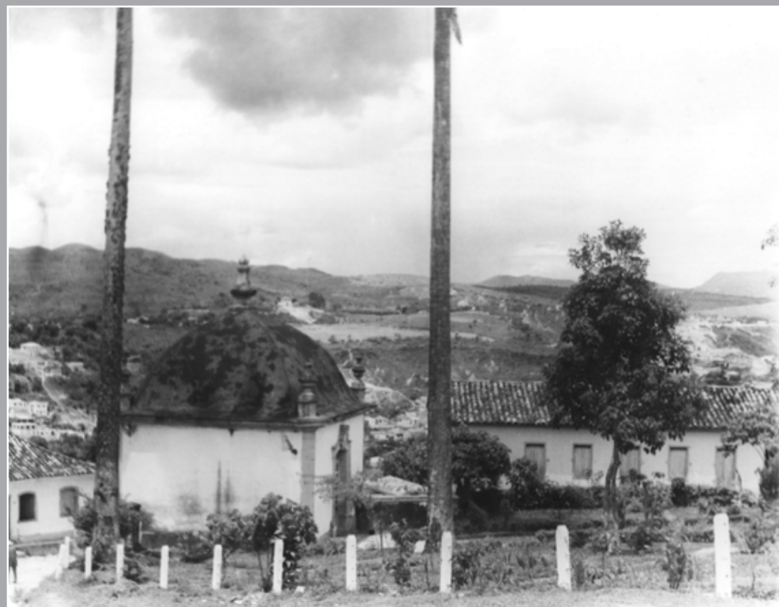
Capela da Santa Ceia com os sítios arqueológicos Mina das Goiabeiras e Mina do Veeiro ao fundo. Sem data, autor desconhecido. Fonte: Prefeitura Municipal de Congonhas.
