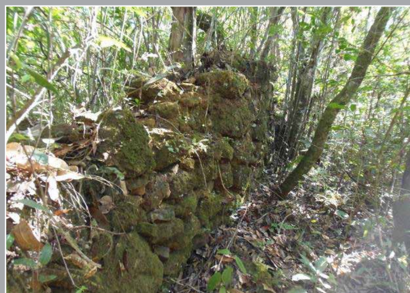
Foto 08 – Muro lateral que ladeia as construções. Região do Veeiro. Foto Henrique Piló, 2014.
