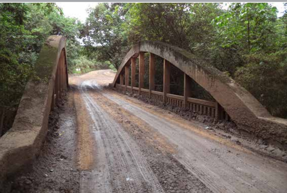
Foto 23 – Vista geral da ponte em arco. Foto: Henrique Piló, 2014.
