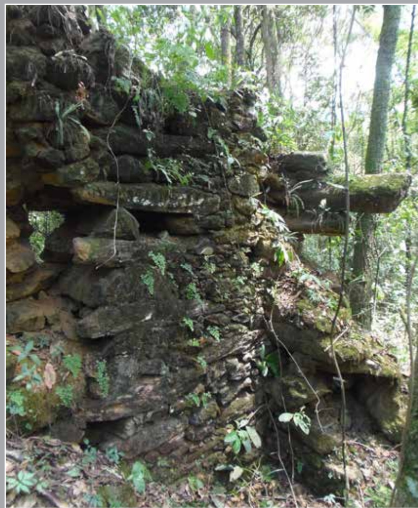
Foto 48 - Trecho da parede do altar-mor. Foto: Henrique Piló, 2014.
