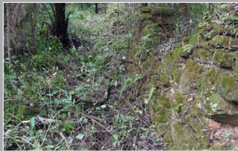
Foto 31 – Vista geral da face interna da parede frontal da edificação de maior volume. Foto: Henrique Piló, 2014.
