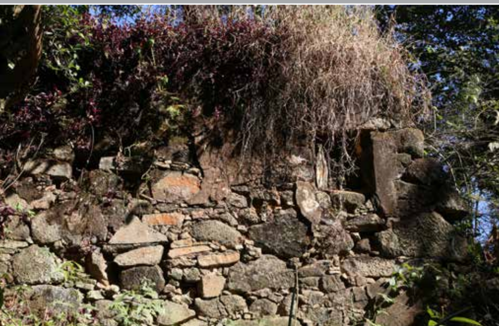
Foto 2 – Detalhe de pequeno vão da janela conservando peças do enquadramento. Foto: Henrique Piló, 2014.
