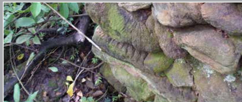
Foto 27 - Detalhe do sistema construtivo das paredes: pedra em junta seca. Foto: Henrique Piló, 2014.
