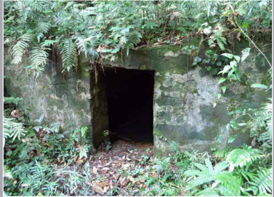
Foto 17 – Túnel provavelmente para transpor um desnivelamento do terreno. Foto: Henrique Piló, 2014.
