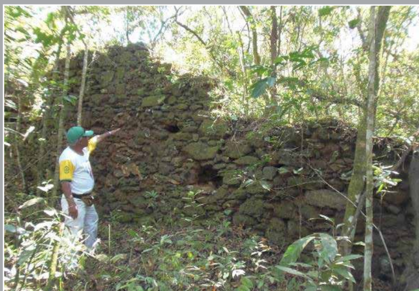
Foto 10 – Vista parcial de uma das paredes ainda bem conservadas. Região do Veeiro. Foto Henrique Piló, 2014.
