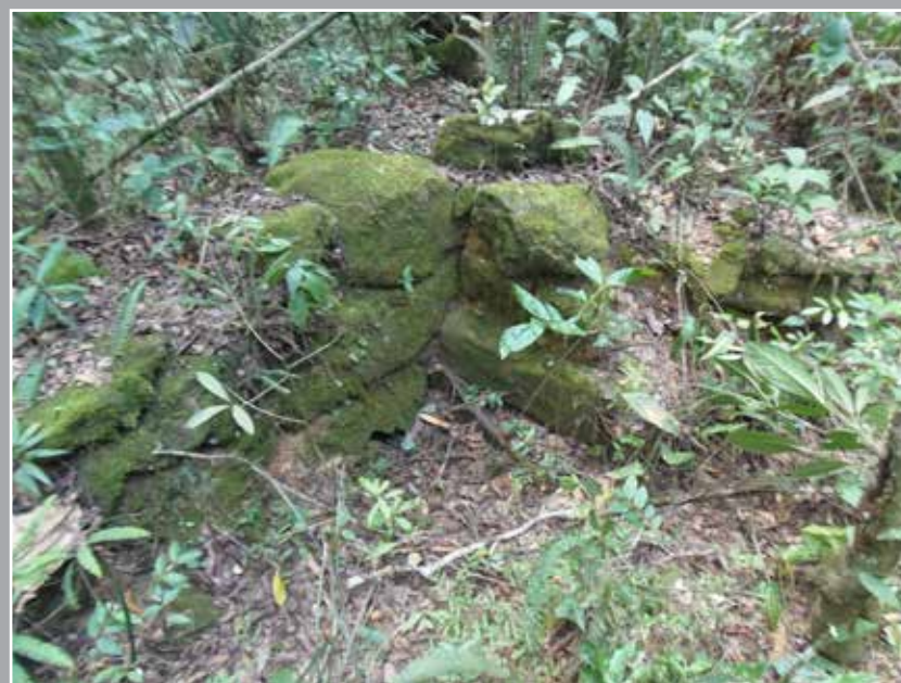
Foto 47 - Detalhe de ângulo interno da alvenaria das paredes. Foto: Henrique Piló, 2014.
