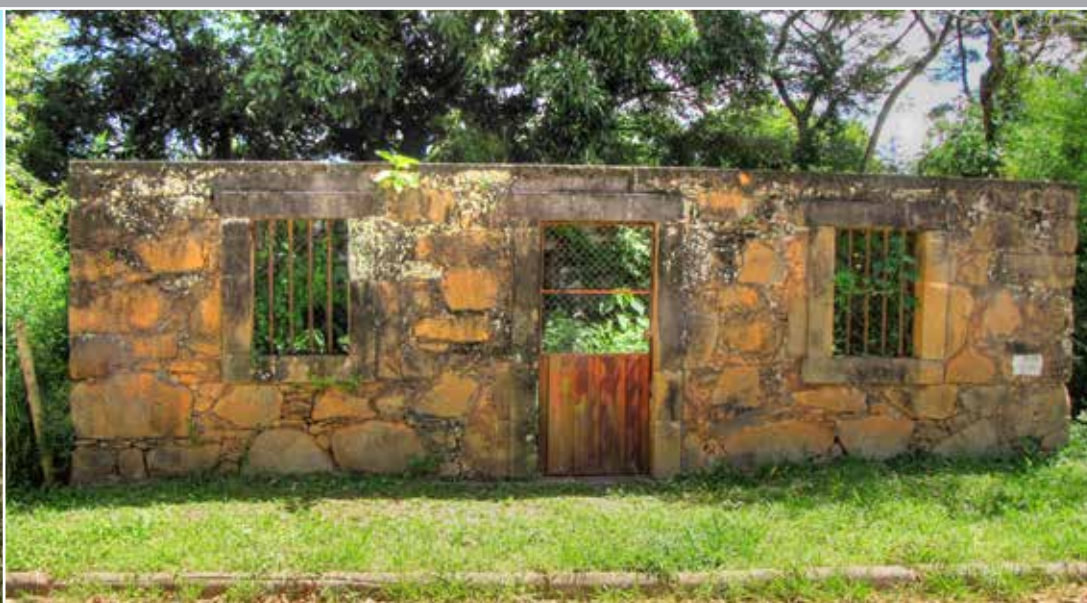
Vista da fachada do prédio da cadeia. Foto Emile Scharlé Jr
