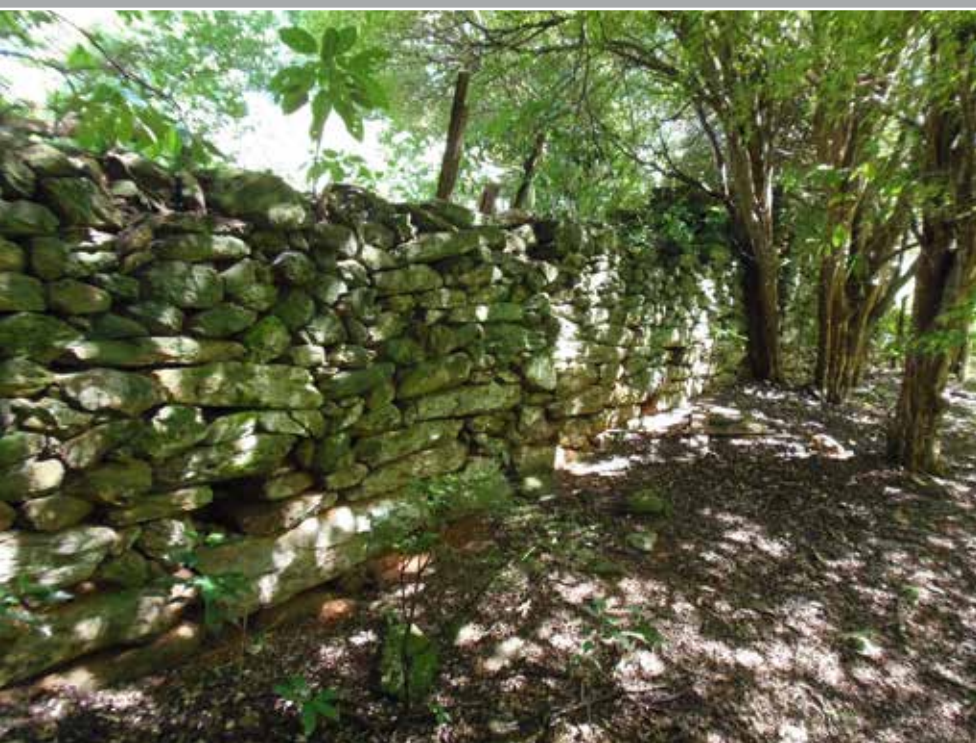
Muro em alvenaria de pedras. Foto: Henrique Piló
