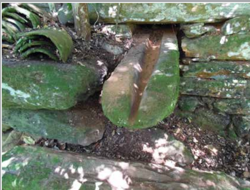
Foto 42 – Detalhe peça esculpida na pedra que conduzia a água ao tanque. Foto: Henrique Piló, 2014.
