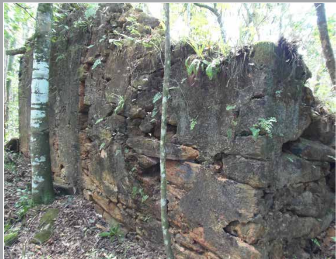
Detalhe da parede externa da capela. Foto: Henrique Piló
