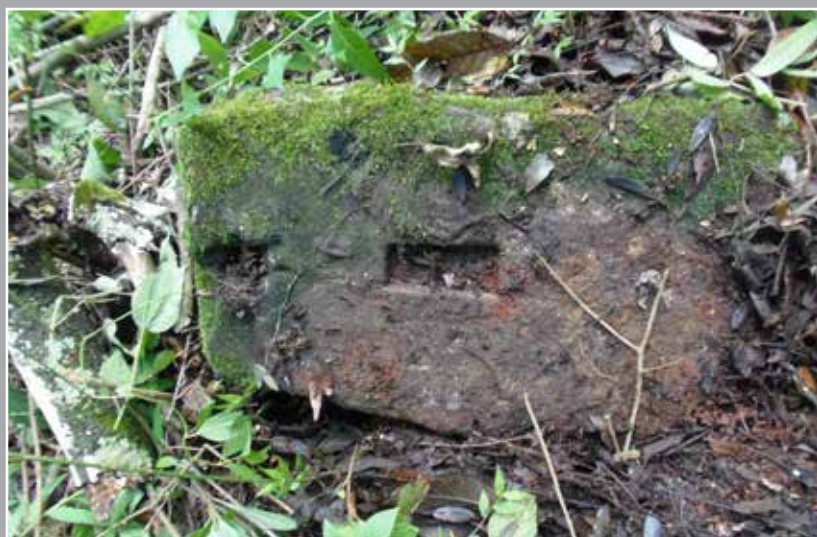
Foto 29 – Pedaco de uma soleira com o encaixe para as ombreiras. Foto: Henrique Piló, 2014.
