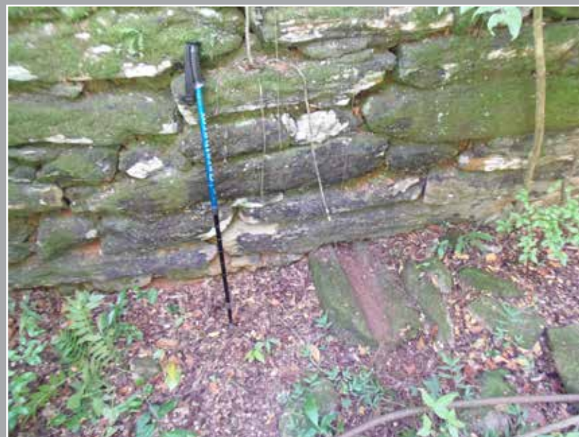
Foto 40 – Canal de drenagem sob o muro esculpido em pedra. Foto: Henrique Piló, 2014.
