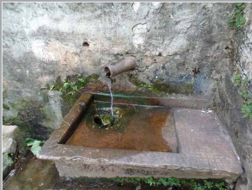
Foto 34- Detalhe da saída d'água em tanque raso. Foto: Henrique Piló, 2014.
